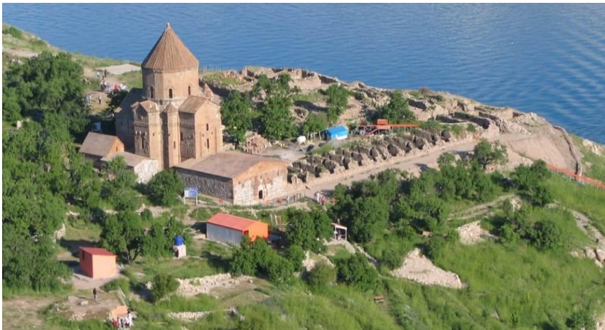
Şekil 67. Akdamar Kilisesi Onarım Çalışmaları Genel Görünüşü (Ş. Öztürk)
