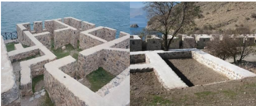
Şekil 74,75. Akdamar Kilisesi Müstemilat Bölümü Onarım Görünüşleri (Ş. Öztürk)
