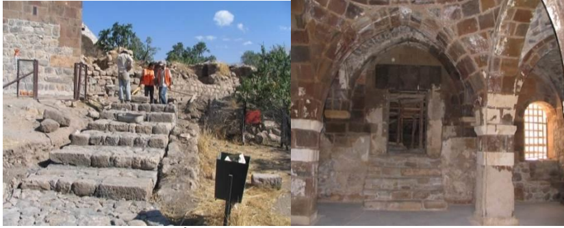
Şekil 72,73. Akdamar Kilisesi İç ve Dış Onarım Çalışmaları Görünüşleri (Ş. Öztürk)
