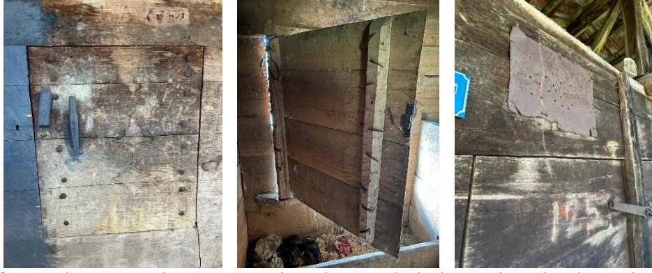
Şekil 11. Ahşap giriş kapısı ve ambar duvarında bulunan havalandırma boşluğu
