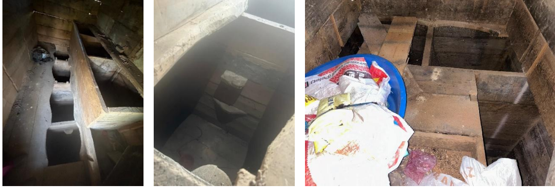
Şekil 13. Ambar yapısının içinde göz denilen derin bölmeler ve sandık formunda kandil bölmeleri
