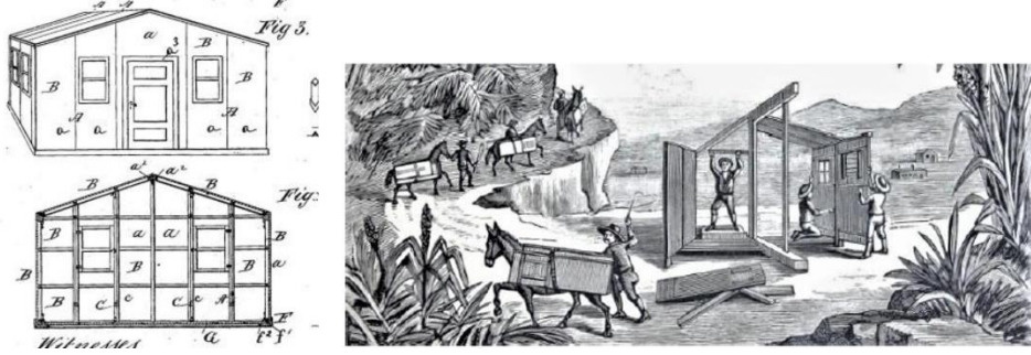
Şekil 4. Panel sistemin kullanıldığı Ducker konutu katalog görselleri (Ducker Portable Houses Co, 1888; Koryciński & Kozakiewicz, 2017)
