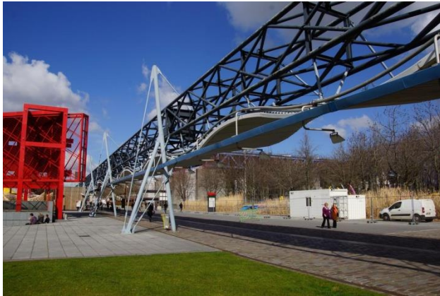
Şekil 5. Parc de la Villette'de strüktürlerin köprüler ve yatay elemanlarla bağlanması (Structurae, 2020)
