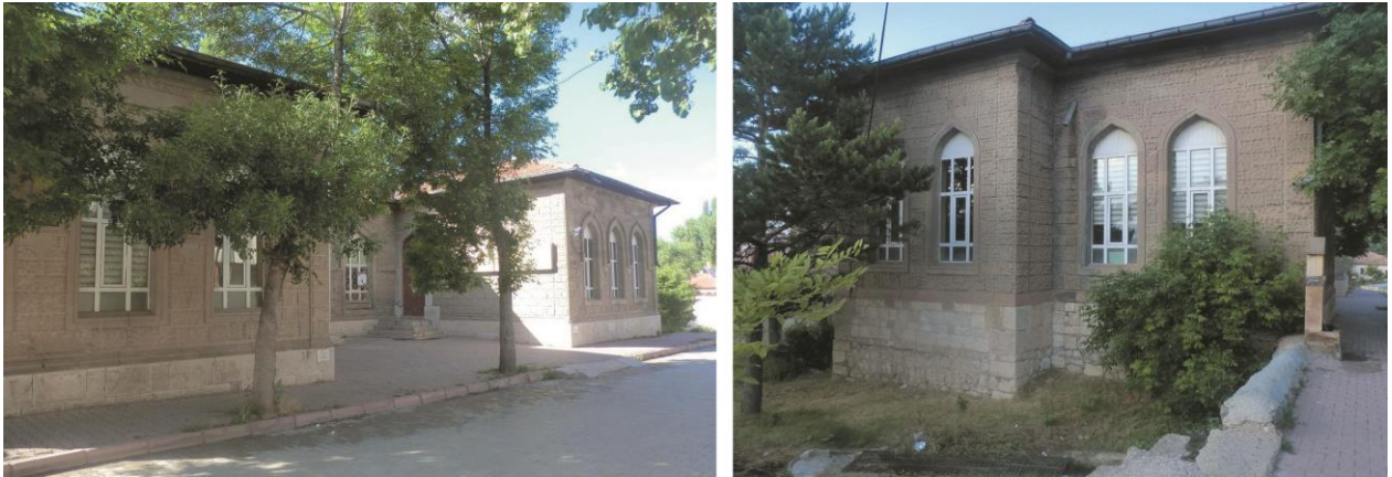
Şekil 21. Barbaros İptidai Mektebinin ön cephe ve batı cephesi fotoğrafları (Y. Mimar Eda Tavacıgil Arşivi).
