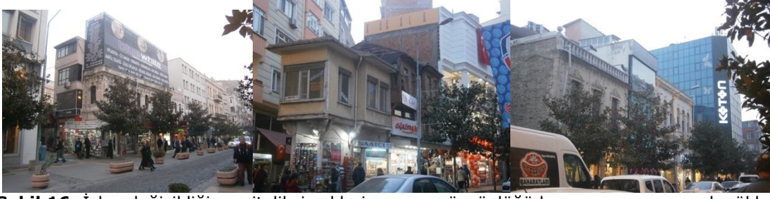
Şekil 16: İşlev değişikliği ve niteliksiz eklerin yapının özgünlüğü bozması ve yapıya ek yükler yüklemesi
