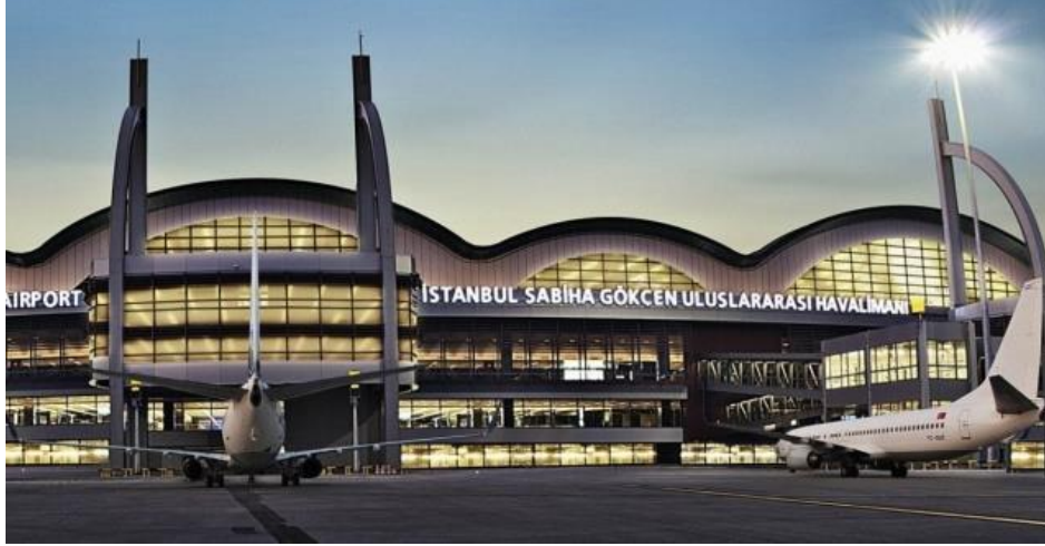
Resim 6: Sabiha Gökçen Havalimanı Terminal Binası, İstanbul, Yeşil Bina Örneği ( www.sabah.com.tr ).
