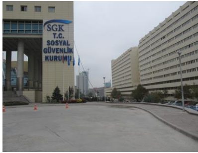
Resim 6. Bağ-Kur Genel Müdürlük Sitesi kuzeyindeki Sayıştay Başkanlığı Hizmet Binası
