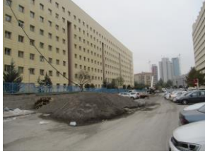
Resim 13. Sayıştay Binası sınırından kuzey ofis bloğu
