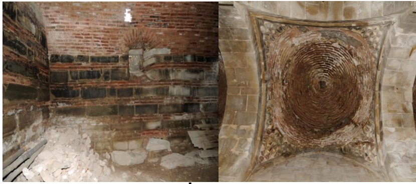
Şekil 71,72. Warak Wank Manastırı İç Mekân Kubbe, Tonz Tuğla ve Yonu Taşı Görünüşleri (Ş. Öztürk)
