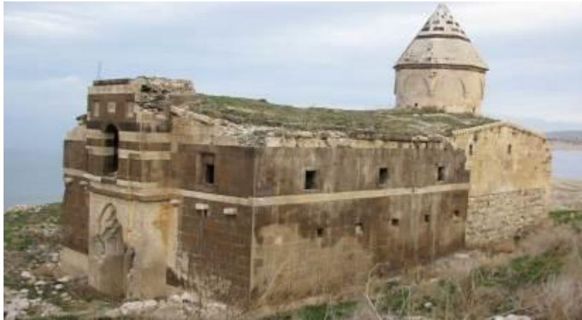
Şekil 31. Jamaton ve Kilise Güneydoğu Genel Görünüşü (Ş. Öztürk)
