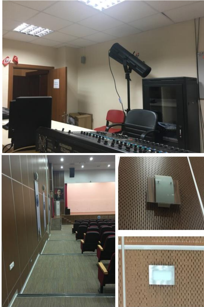
Şekil 3. Reji Odası, Salon Duvar ve Zemin Aydınlatması.
