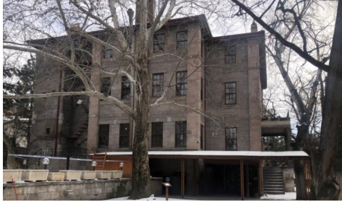
Fotoğraf 2: Yapının kuzey görünümü (Akdağ, 2020)
