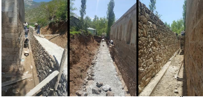
Şekil 64-66. İstinat Duvarı Yapım Görünüşleri (Ş. Öztürk)
