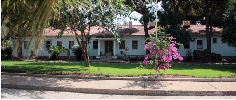
Resim 16 - Kreş yapısı kuzeydoğu cephesi, 2015.
