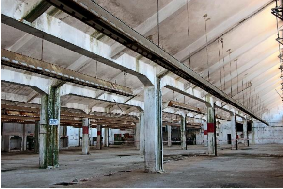
Resim 4 - İşletme yapısı iç mekân, 2015.
