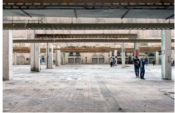
Resim 5 - İşletme yapısı iç mekân, 2015.
