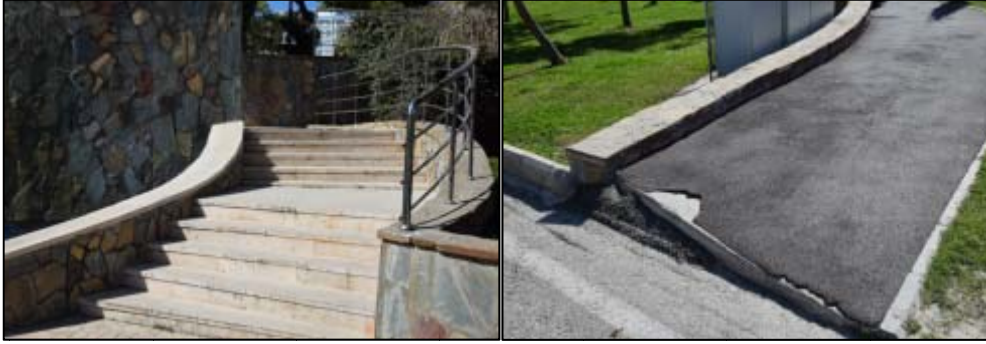
Şekil 2. Yol, rampa ve merdivenlere ait genel görünüşler (Orijinal, 2019)
