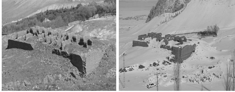
Fotoğraf-21,22: Hükümet Konağı Güneydoğu Genel Görünüşleri (Ş. Öztürk)
