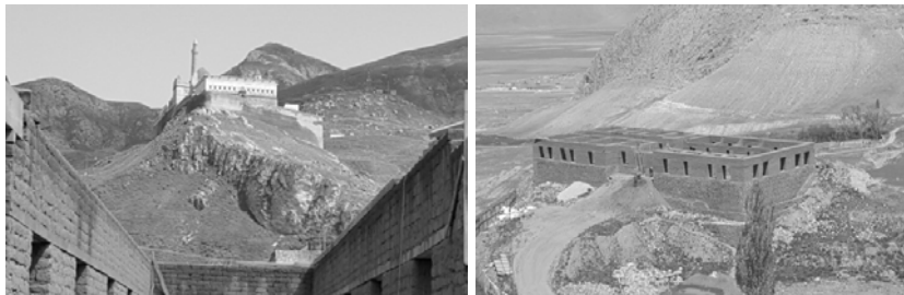
Fotoğraf-42,43: Hükümet Konağı Kerpiç Duvar Yapım Görünüşleri (Ş. Öztürk)
