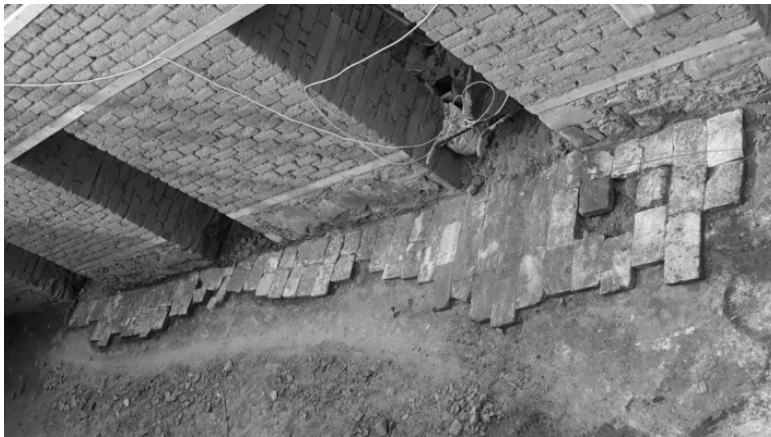
Fotoğraf-48: Hükümet Konağı Kazı Sonrası Koridor Özgün Yonu Taş Kaplama Görünüşü (Ş. Öztürk)
