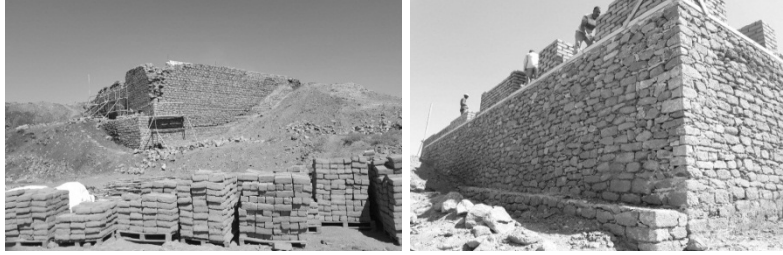
Fotoğraf-32,33: Hükümet Konağı Güneydoğu Moloz Taş Duvar Görünüşleri (Ş. Öztürk)
