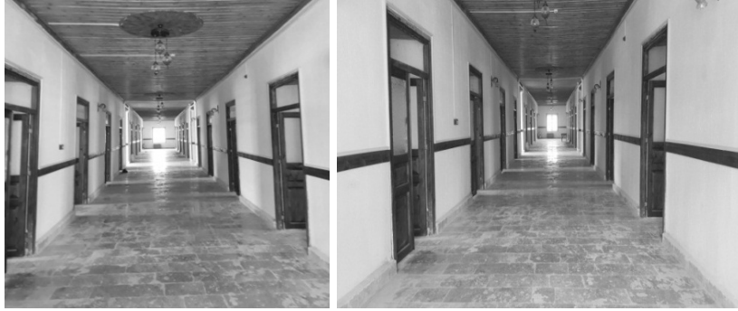
Fotoğraf-49,50: Hükümet Konağı Onarım Sonrası Koridor Görünüşleri (Ş. Öztürk)
