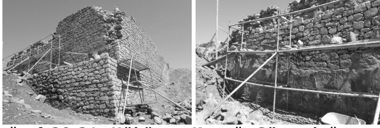
Fotoğraf-30,31: Hükümet Konağı Güneydoğu ve Batı Moloz Taş Duvar Görünüşleri (Ş. Öztürk)
