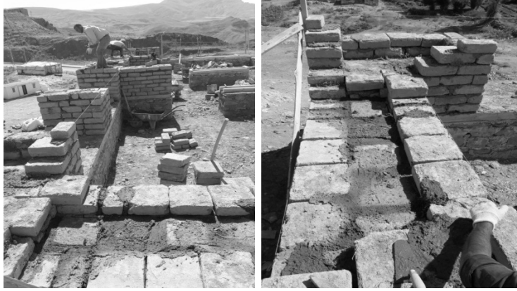
Fotoğraf-38,39: Hükümet Konağı Kerpiç Duvar Yapım Görünüşleri (Ş. Öztürk)
