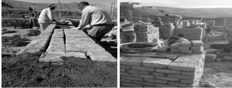
Fotoğraf-36,37: Hükümet Konağı Kerpiç Duvar Yapım Görünüşleri (Ş. Öztürk)
