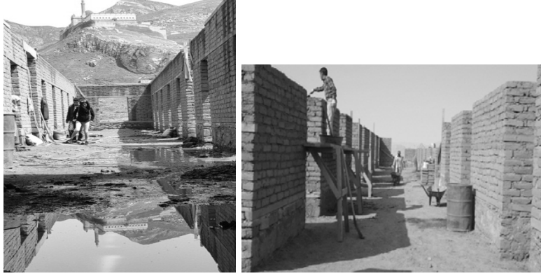
Fotoğraf-44,45: Hükümet Konağı Kerpiç Duvar Yapım Görünüşleri (Ş. Öztürk)
