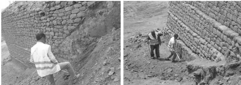
Fotoğraf-28,29: Hükümet Konağı Doğu Moloz Taş Duvar Görünüşleri (Ş. Öztürk)
