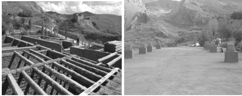
Fotoğraf-46,47: Hükümet Konağı Kerpiç Düz Toprak Dam Yapım Görünüşleri (Ş. Öztürk)
