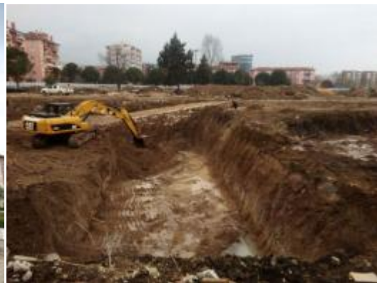
Şekil 17. A Sitesi temel kazısı, 2018 (Anonim 5, 2018)
