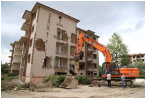
Şekil 16. B Sitesi yıkım çalışmaları, 2017 (Anonim 4, 2017)
