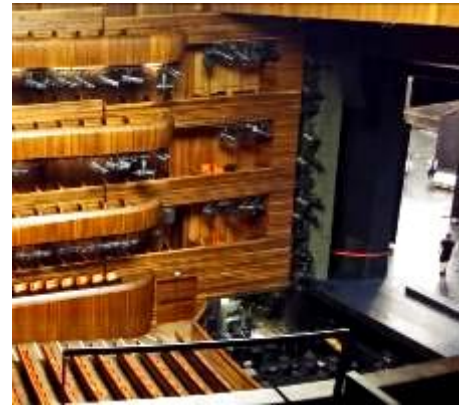
Şekil 32. Projektörlerin yerleştirildiği teknik birimler ile balkon ve sahne önü bölümündeki teknik kule (Mustafa KAVRAZ)
