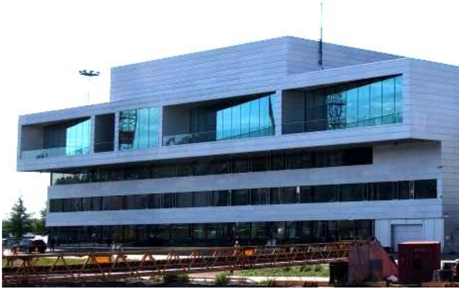
Şekil 38. Opera binasının koro ve bale prova odalarının bulunduğu doğu cephesi (Mustafa KAVRAZ)
