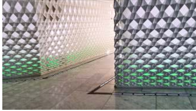
Şekil 24. Duvar yüzeyi panel bağlantısı ile aydınlatma elemanları (Mustafa KAVRAZ)
