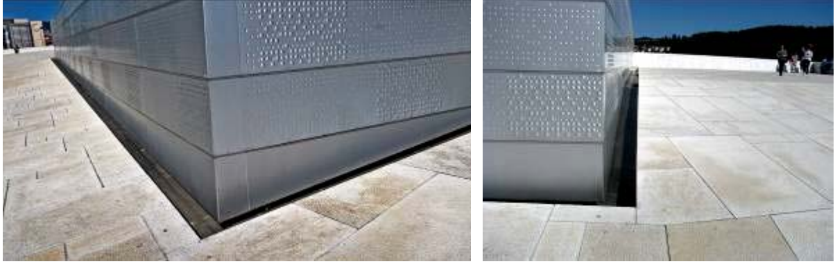
Şekil 14. Alüminyum kaplı kulelerin döşemeyle birleşimlerindeki su tahliye kanalları (Mustafa KAVRAZ)
