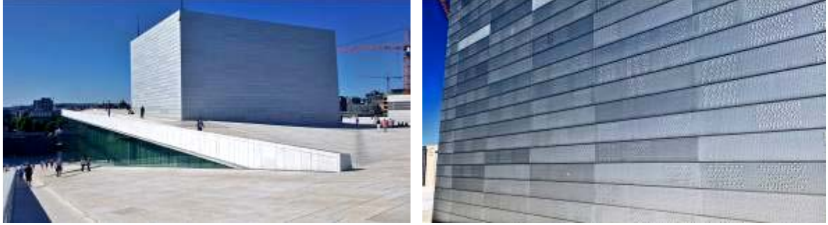
Şekil 16. Kule biçiminde çatı düzleminde üst kotlara yükselen birimlerde, gözenekli motiflere sahip alüminyum levha ile kaplanmış yüzeyler (Mustafa KAVRAZ)
