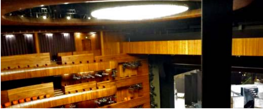
Şekil 33. Tavan yüzeyinde yer alan oval ses yansıtıcı yüzey ve içinde yer alan avize (Mustafa KAVRAZ)
