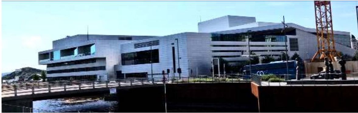
Şekil 15. İmalat birimleri, yönetim ve sahne arkası birimlerinin yer aldığı alüminyum metal levha-cam kaplı yüzeyler (Mustafa KAVRAZ)
