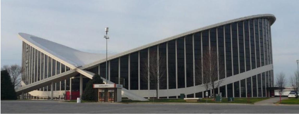
Şekil 28. J.S. Dorton Arena binasının çatısı- Kablo ağının iki kenar kemere tutturulduğu bir hiperbolik parabolit çatı örneği (URL-9)
