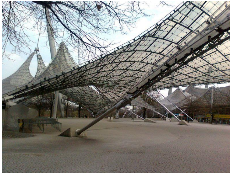
Şekil 45. Münih Olimpiyat Stadyumunun çatısı- Şeffaf akrilik panel kaplama (URL-22)
