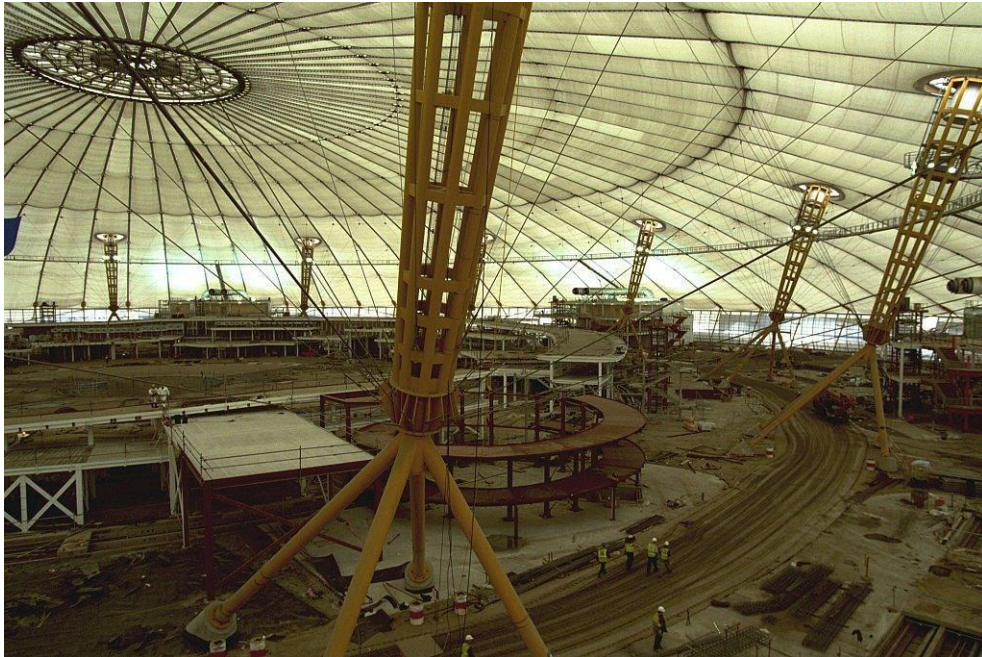
Şekil 49. Londra Milenyum Kubbesi binasının çatısı- İçten görünüş (URL-27)
