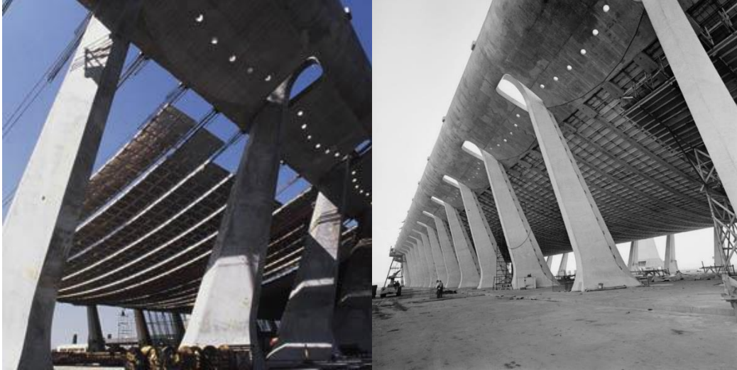
Şekil 7. Dulles Uluslararası Havalimanı binasının çatı inşaatı (URL-1)
