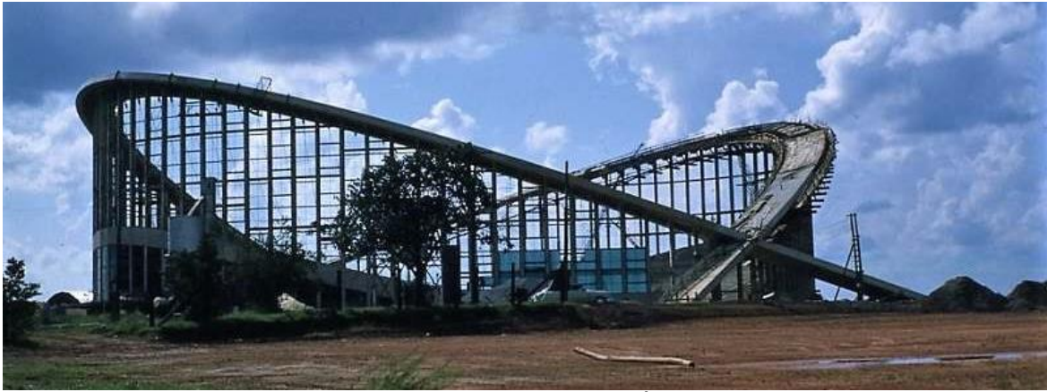
Şekil 29. J.S. Dorton Arena binasının çatısı- İnşaat aşaması (URL-10)
