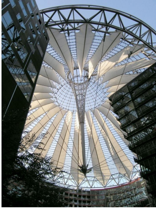
Şekil 42. Sony Center binasının çatısı- Kablo ağının yüksek nokta desteğinin çatının alt kenarında düzenlenen uzay kafes kirişe asılması (URL-18)
