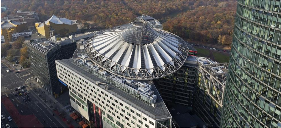
Şekil 40. Sony Center binasının çatısı- Kablo ağı ile oluşturulmuş ve yüksek noktası dolaylı olarak desteklenmiş bir çadır çatı örneği (URL-16)
