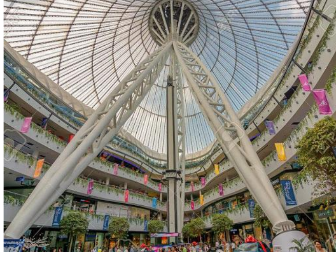
Şekil 39. Han Çadırı binasının çatısı- İçten görünüş (URL-15)
