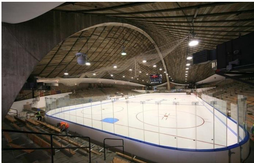
Şekil 33. Ingalls Buz Hokeyi Salonunun çatısı- İçten görünüş (URL-13)
