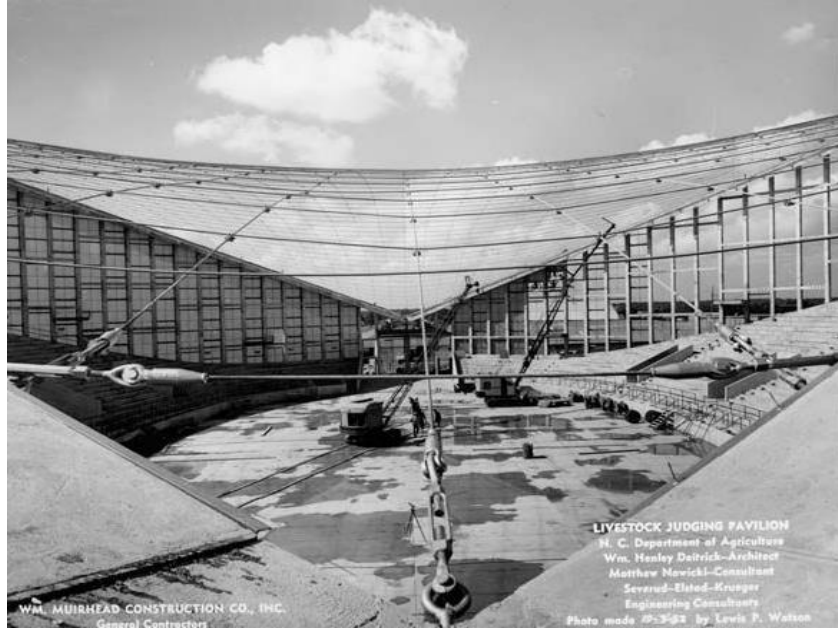
Şekil 30. J.S. Dorton Arena binasının çatısı- Kablo ağı (URL-11)
