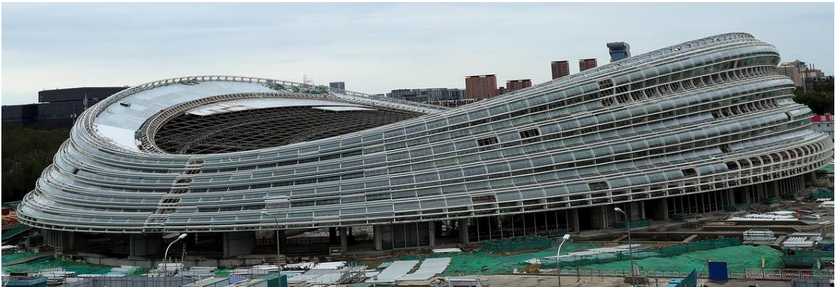
Şekil 22. National Speed Skating Oval (NSSO) binasının çatısı- Kablo ağının, kenarlarda düzenlenen uzay kafes kirişlere tutturulduğu bir hiperbolik paraboloid çatı örneği (URL-5)
