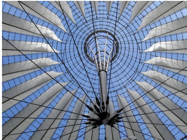
Şekil 41. Sony Center binasının çatısı- Kablo ağının yüksek nokta desteği (URL-17)
