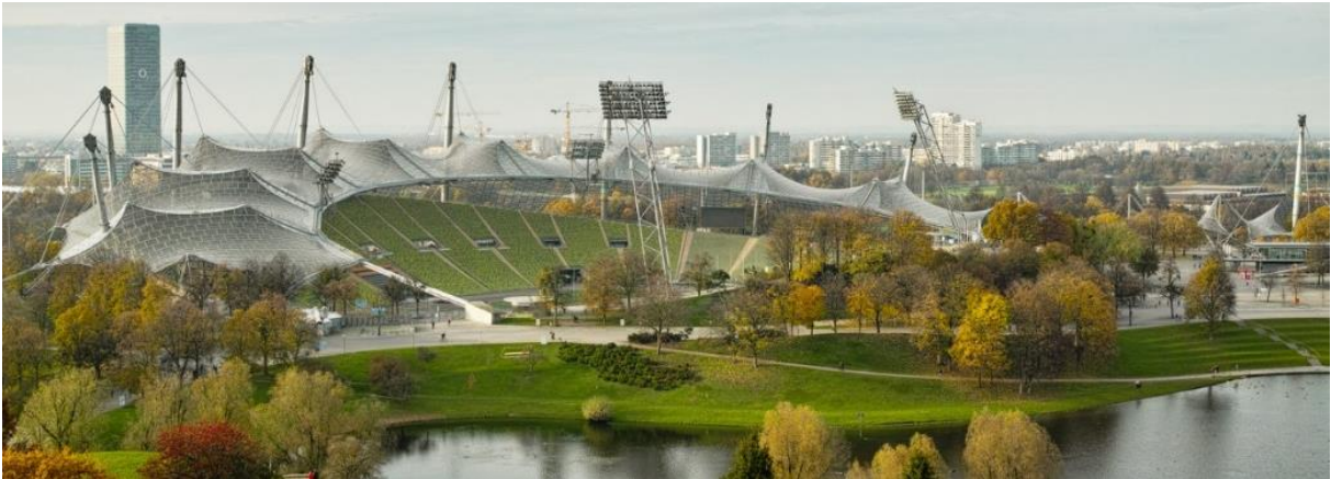
Şekil 43. Münih Olimpiyat Stadyumunun çatısı- Kablo ağı ile oluşturulmuş ve yüksek noktaları dolaylı olarak desteklenmiş bir çadır çatı örneği (URL-19)
