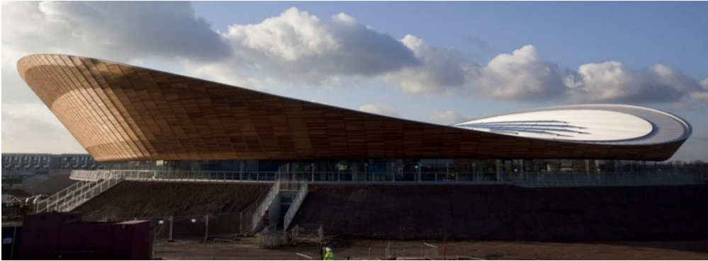
Şekil 24. Lee Valley Velodromunun çatısı- Kablo ağının, kenarlarda düzenlenen uzay kafes kirişlere tutturulduğu bir hiperbolik parabolit çatı örneği (URL-8)
