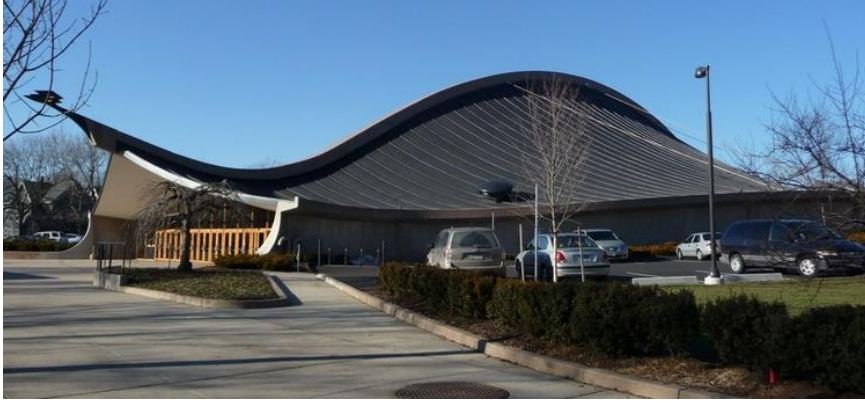
Şekil 31. Ingalls Buz Hokeyi Salonunun çatısı- Kablo ağının, bir ara ve iki kenar kemere tutturulduğu bir hiperbolik parabolit çatı örneği (URL-12)
