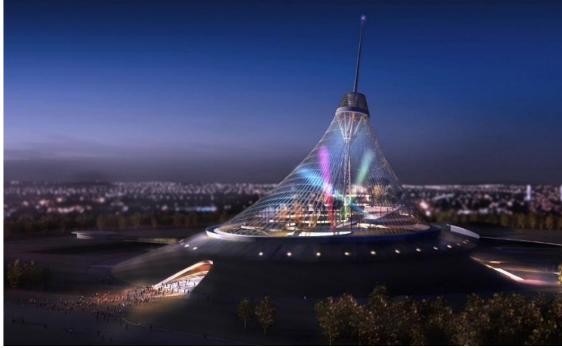
Şekil 37. Han Çadırı binasının çatısı- Kablo ağı ile oluşturulmuş ve yüksek noktası doğrudan kolonla desteklenmiş bir çadır çatı örneği (URL-14)
