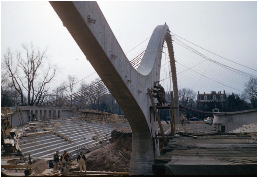
Şekil 32. Ingalls Buz Hokeyi Salonunun çatısı- Kabloların kemere montaj aşaması (URL-13)
