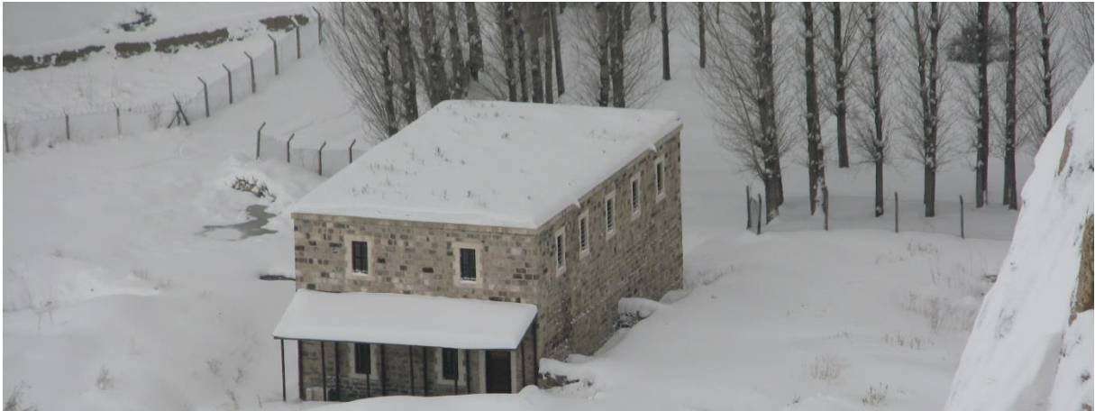
Şekil 7. Horhor Camii Onarım Sonrası Kuzeydoğu Genel Görünüşü (Kaynak: Ş. Öztürk, 2008)
