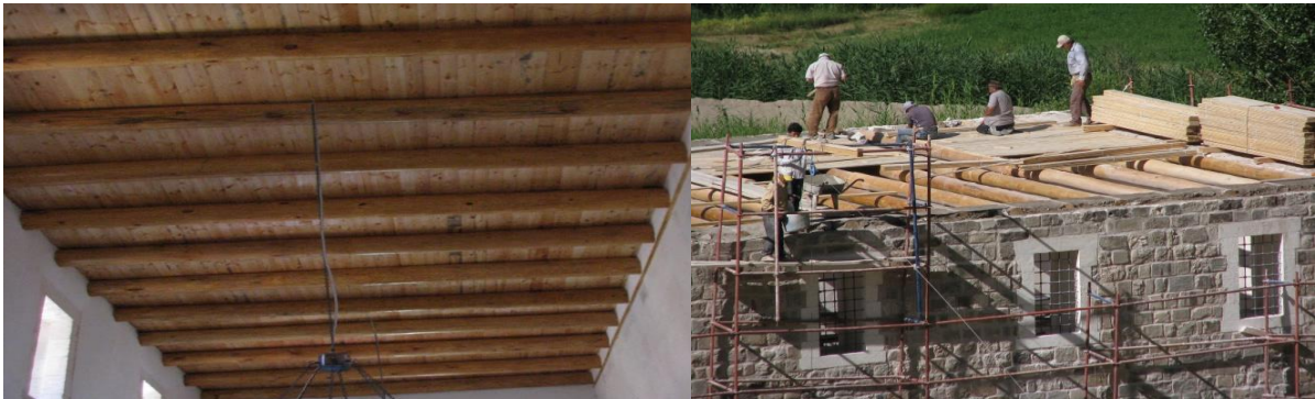
Şekil 103,104. Horhor Camii İç Mekân ve Düz Dam Ahşap Onarım Çalışma Görünüşleri (Kaynak: Ş. Öztürk, 2011)
