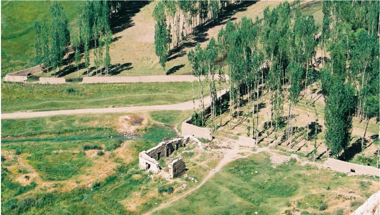
Şekil 4. Horhor Camii Kazı ve Onarım Öncesi Kuzeydoğu Görünüşü (Kaynak: Ş. Öztürk 2008)
