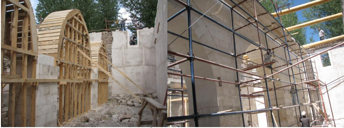
Şekil 101,102. Horhor Camii İç Mekân Onarım Çalışma Görünüşleri (Kaynak: Ş. Öztürk, 2011)
