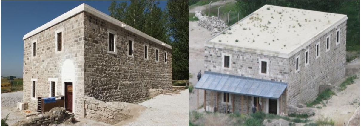
Şekil 31,32. Horhor Camii Kuzeydoğu Genel Görünüşleri (Kaynak: Ş. Öztürk, 2011)
