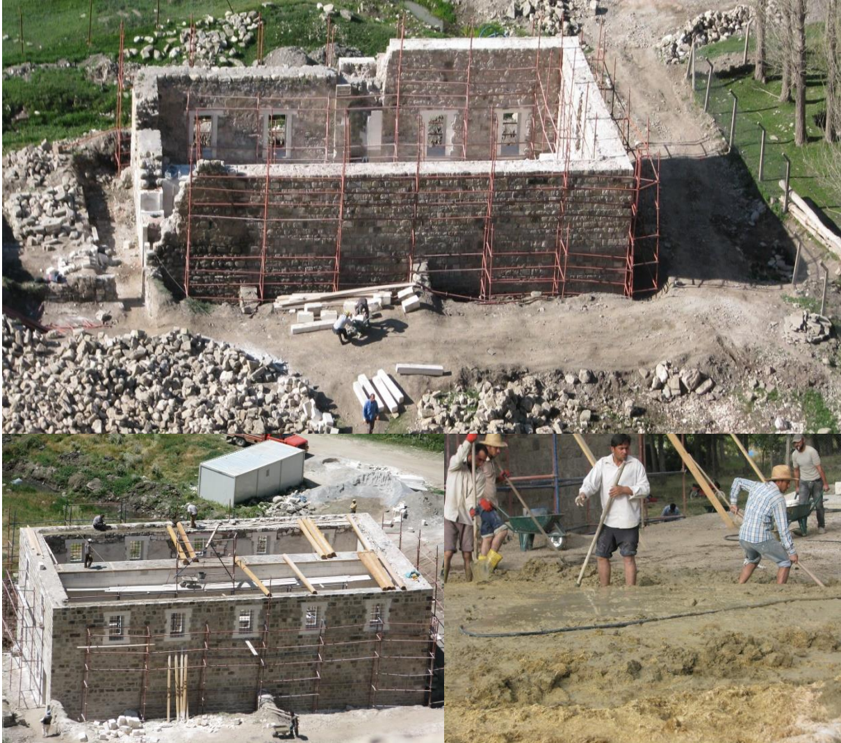
Şekil 97-99. Horhor Camii Beden Duvarları Onarım Çalışma Görünüşleri (Kaynak: Ş. Öztürk, 2011)
