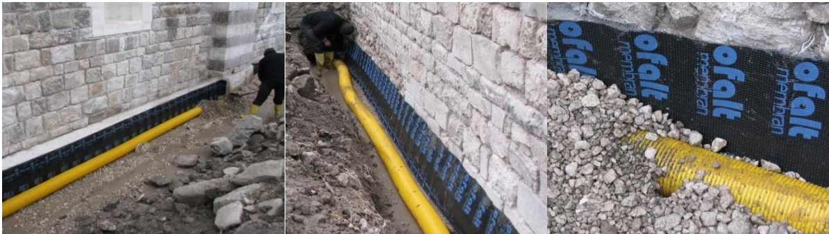
Şekil 107-109. Horhor Camii Beden Duvarları Drenaj Onarım Çalışma Görünüşleri (Kaynak: Ş. Öztürk, 2011)
