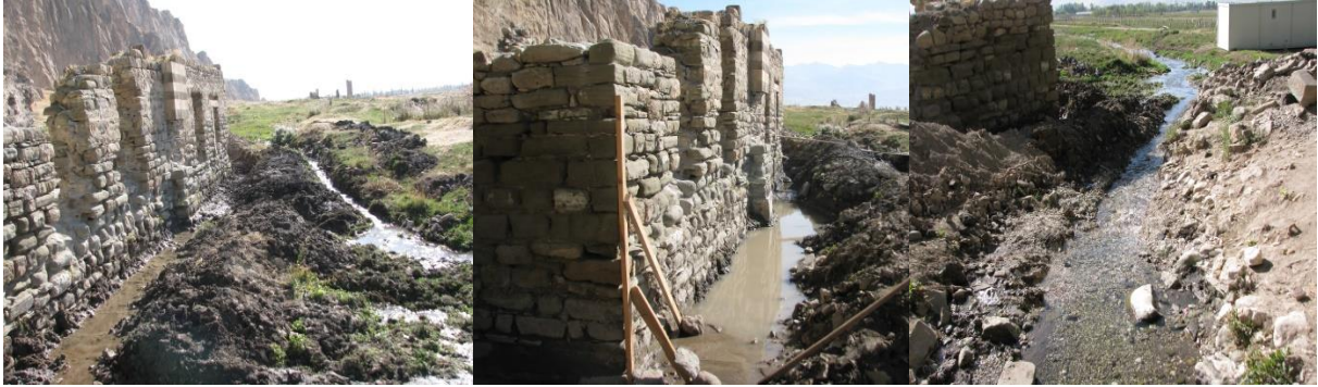
Şekil 105,106. Horhor Camii Beden Duvarları Drenaj Onarım Çalışma Görünüşleri (Kaynak: Ş. Öztürk, 2011)
