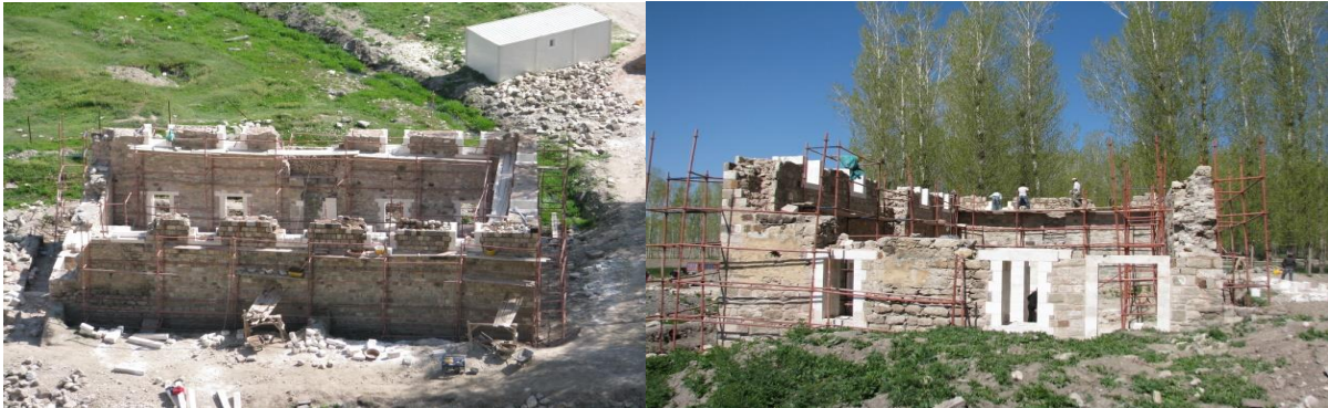
Şekil 92,93. Horhor Camii Beden Duvarları Onarım Çalışmalarında Görünüşler (Kaynak: Ş. Öztürk, 2011)
