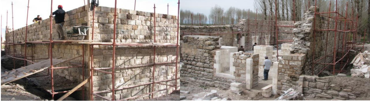
Şekil 90,91. Horhor Camii Beden Duvarları Onarım Çalışma Görünüşleri (Kaynak: Ş. Öztürk, 2011)
