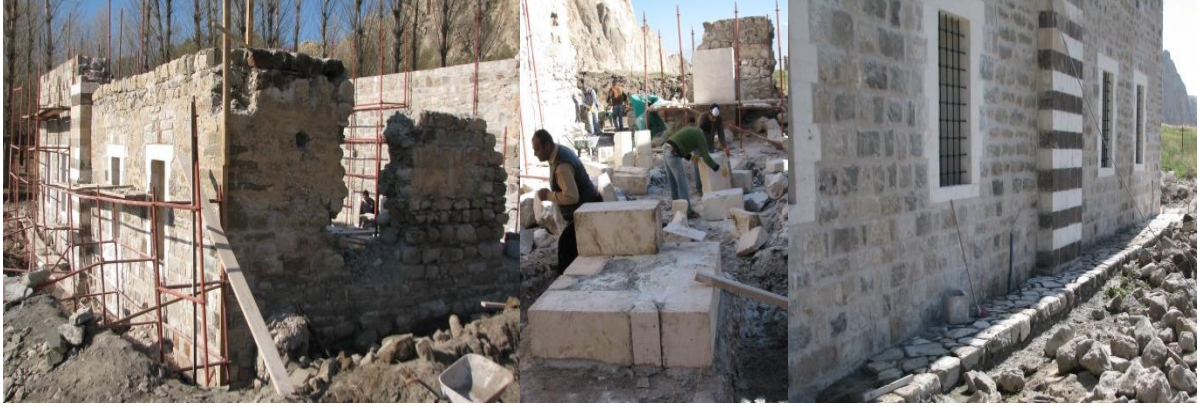
Şekil 94-96. Horhor Camii Beden Duvarları Onarım Çalışma Görünüşleri (Kaynak: Ş. Öztürk, 2011)
