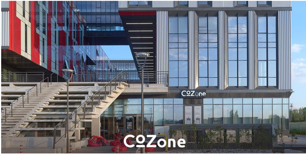
Şekil 1. ODTÜ Teknokent binası CoZone paylaşımlı ofis cephe görünüşü ( https://cozone.co/ , 2020)
