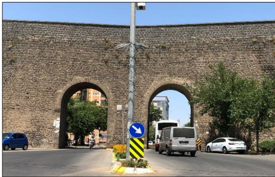
Foto 2: Çift Kapı Sur İçi Cephesi (2020)
