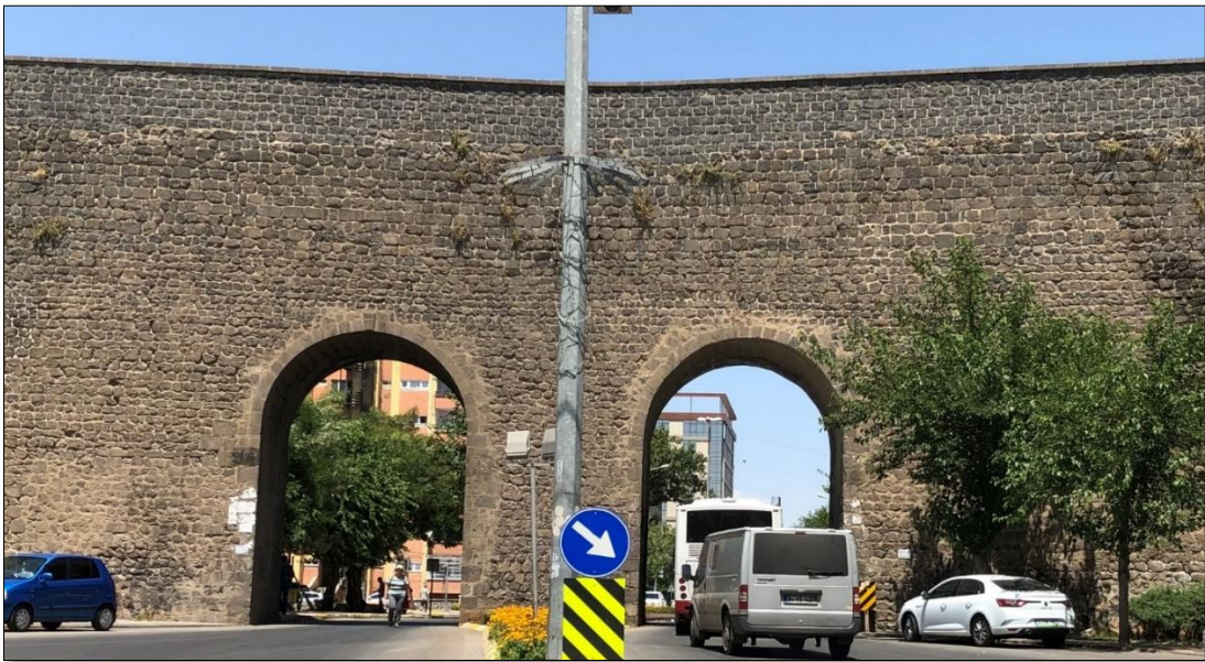
Foto 3: Çift Kapı Sur İçi Cephesi (2020)
