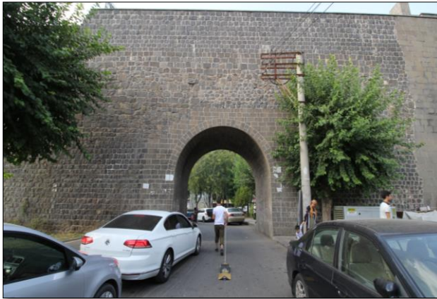
Foto 11: Tek Kapı Sur İçi Cephesi (2020) Rölöve ve Anıtlar Müdürlüğü. Arşivi)
