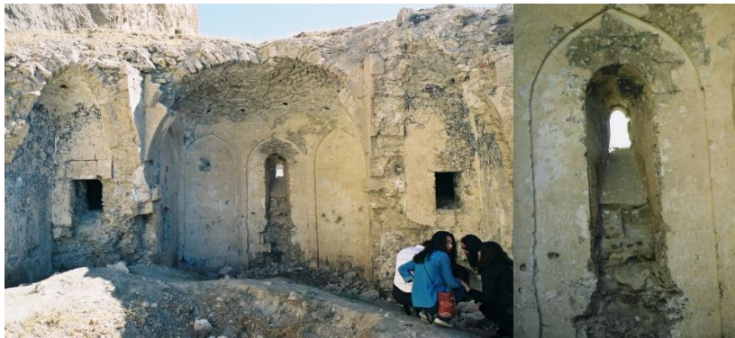
Şekil 23,24. Surp Vardan Kilisesi İç Mekan ve Mazgal Pencere Genel Görünüşleri (Kaynak: Ş. Öztürk, 2012)
