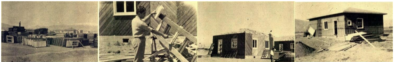
Şekil 7. Erzincan depremi sonrası Avusturya'dan gönderilen konut bileşenlerinin sahada istiflenmesi, inşası ve bitmiş hali (soldan sağa) (Koyuncuoğlu, 1977; Orhan, 2019)
