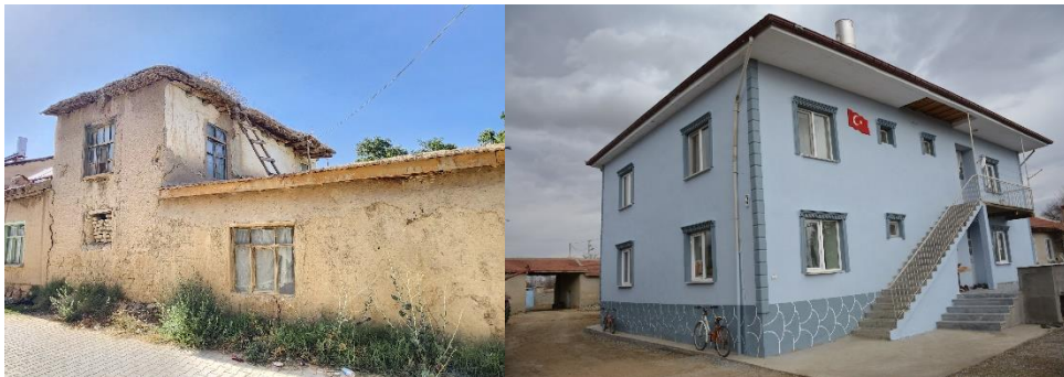
Şekil 3. Toprak dam-toprak siva (solda), Kiremit örtü-çimento katkılı siva (sağda) (Kişisel Arşiv, 2023)
