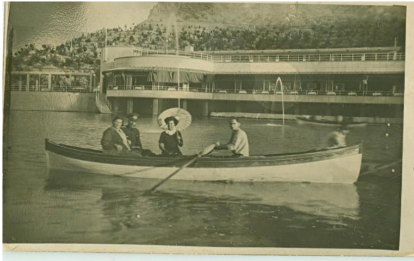
Şekil 5 - Çubuk Barajında Lokanta ve Gazino yapısının arka planda görülebildiği, havuzdan çekilmiş 1938 yılına ait bir fotoğraf. Fotoğrafta yapının mimari kütlelerinin piloti benzeri kolonlar üzerinde taşındığı, bu kolonların dairesel gazino kısmında öne çıktığı, öne çıkan bölümün yanından kayıklara erişimin sağlandığı dairesel merdiven, yataylığın vurgulandığı cephede devam eden cam açıklıklar, üst kattaki açık teras alanı ve gazinonun yanında yer alan pergola görülebilmektedir. Kaynak: Çubuk Barajı'nda Kayıkla Gezinti, 1938
