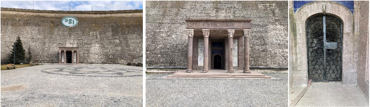
Şekil 15 – Yürüyüş yolunun sonundaki portikoyu, mukarnas başlıklı dört sütunun kullanıldığı portiko platformunu ve bu alandan barajın içine uzanan yolun kapısını gösteren 2023 yılına ait fotoğraflar. Kaynak: Gizem Yakupoğlu Arşivi
