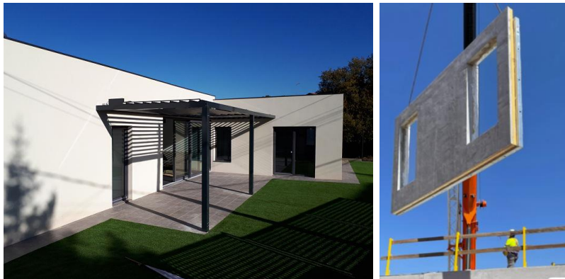
Şekil 12. Prefabrik kompozit panel kullanılarak inşa edilen 8 numaralı yapı (URL-15) (URL-16)
