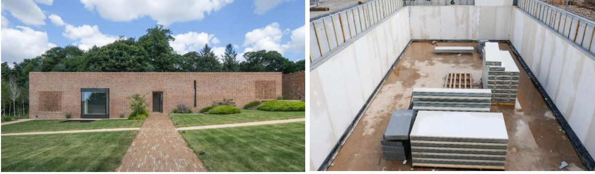
Şekil 15. Prefabrik kompozit panel kullanılarak inşa edilen 11 numaralı yapı (URL-21) (URL-22) (URL-23)
