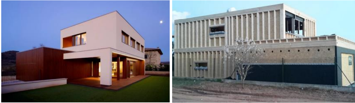
Şekil 14. Prefabrik ahşap iskelet ve prefabrik ahşap panel ile inşa edilen 10 numaralı yapı (URL-19) (URL-20)
