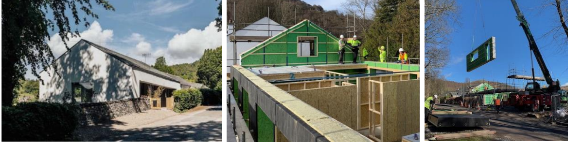
Şekil 9. 5 numaralı yapı ve yapıda kullanılan prefabrik panel montajı (URL-10) (URL-11)
