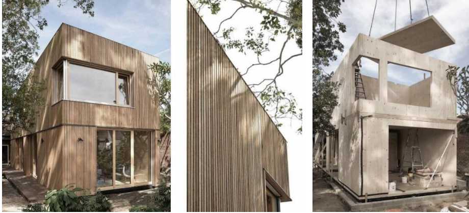
Şekil 11. Prefabrik ahşap panellerle inşa edilen 7 numaralı yapı (URL-13) (URL-14)
