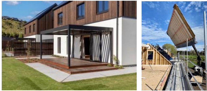
Şekil 5. 1 numaralı yapı ve prefabrik panel montajı (URL-3)
