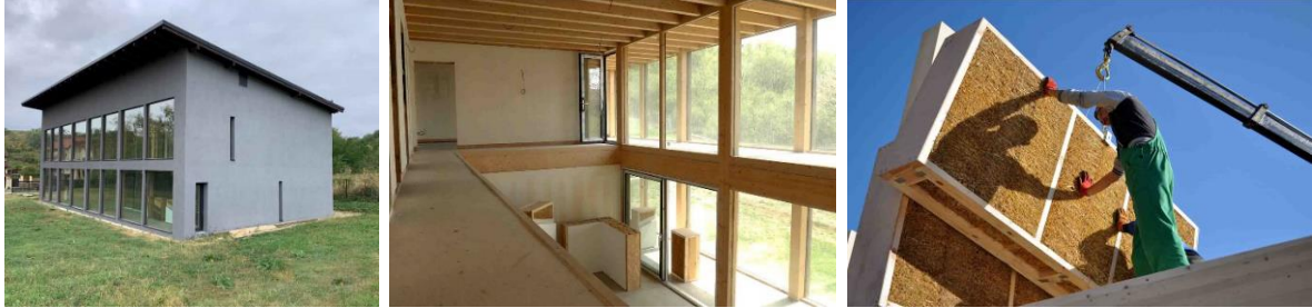
Şekil 8. 4 numaralı yapı, prefabrik iskelet ve panel kullanımı (URL-8) (URL-9)
