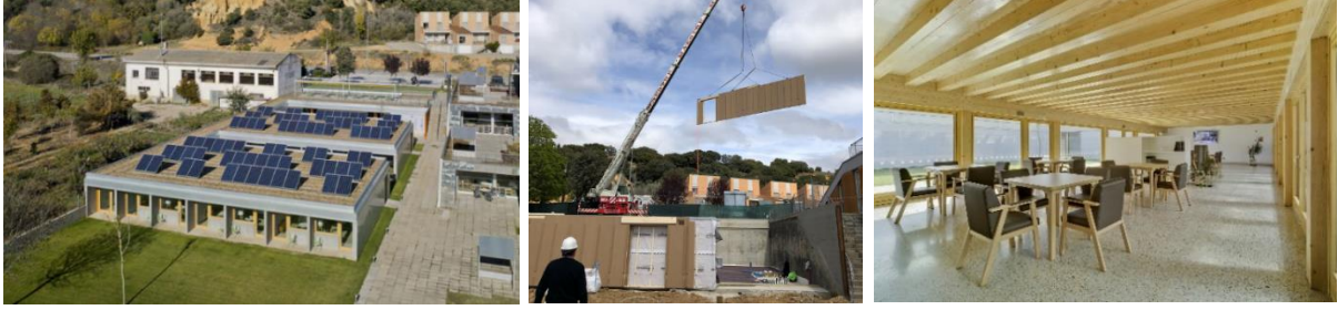
Şekil 13. Prefabrik ahşap iskelet ve ahşap panel kullanılarak inşa edilen 9 numaralı yapı (URL-17) (URL-18)
