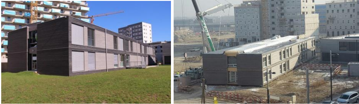
Şekil 16. Prefabrik hücre sistem kullanılarak inşa edilen 12 numaralı yapı (URL-24)
