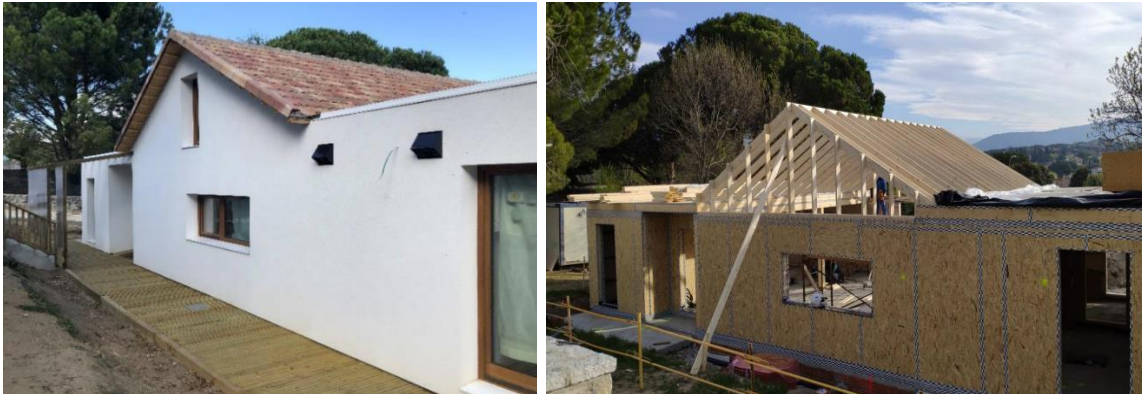
Şekil 6. 2 numaralı yapı görseli, ahşap prefabrik iskelet ve panel sistem (URL-5)
