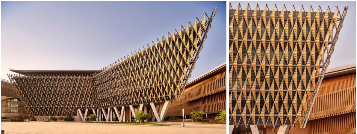
Şekil 13: Eğimli Yapı Cephesi ve Güneş Kırıcı Paneller (URL1)
