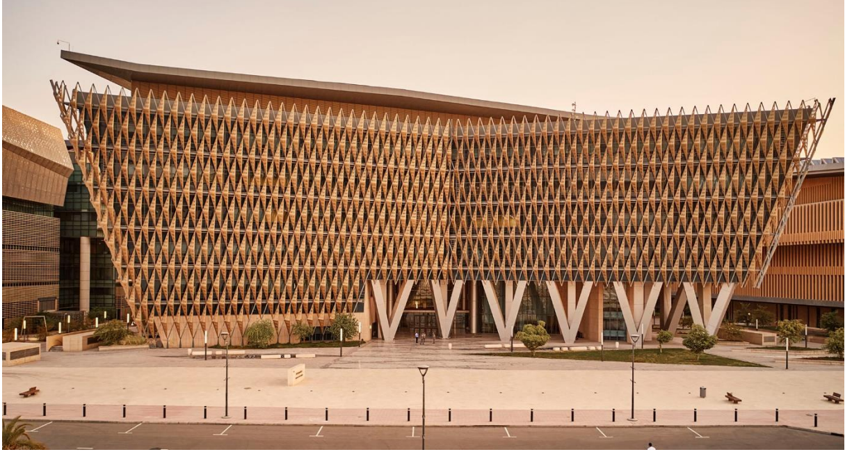
Şekil 11: Yapı Cephesi (URL5)
