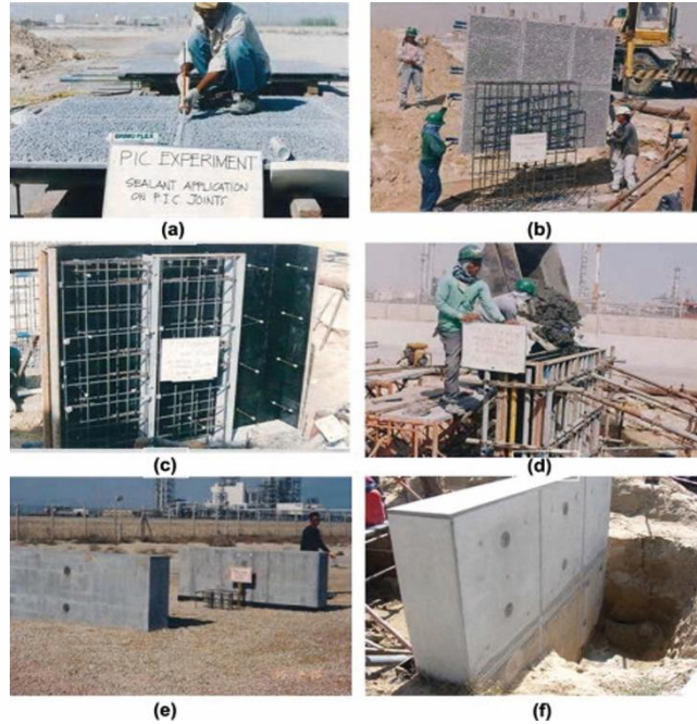
Şekil 5. (a-f) Polimer betonun montajı ve dökümü (Bhutta vd., 2013)
