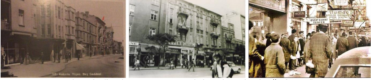
Görsel 14. (Sol) Sakarya Apartmanı sokak cephesinden fotoğraf-1930'lar (Orta) Sakarya Apartmanı giriş cephesini gösteren fotoğraf- 1950'ler (Sağ) Sakarya Apartmanı giriş cephesini gösteren fotoğraf (Eyüp Sabri Tuncer tabelası dikkat çekmektedir)- 1970'ler
