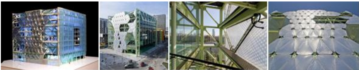
Fotoğraf 5. Media-TIC Ofis Binası (Archdaily, 2010; Arkitektuel, 2018)
