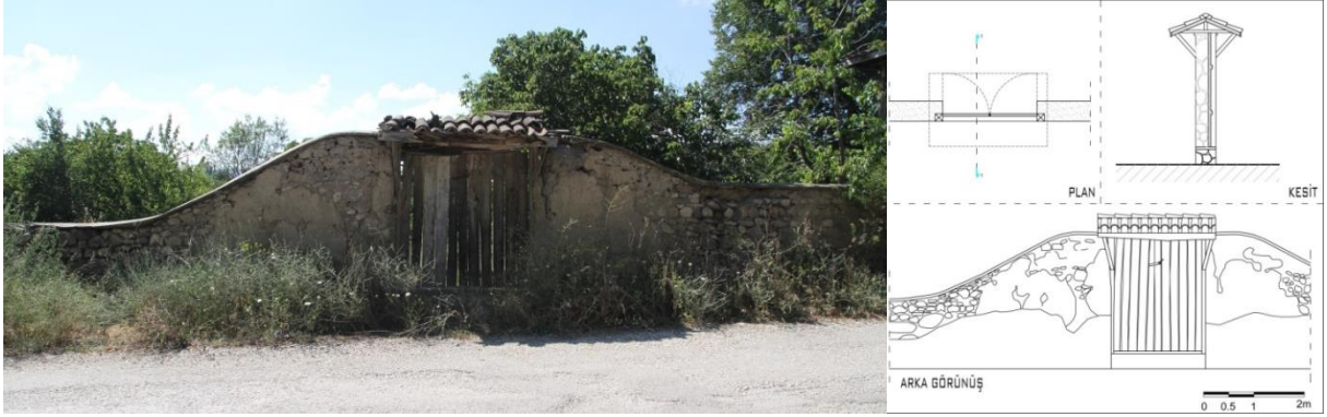
Şekil 18. Çift kanatlı ahşap bağ kapısı
