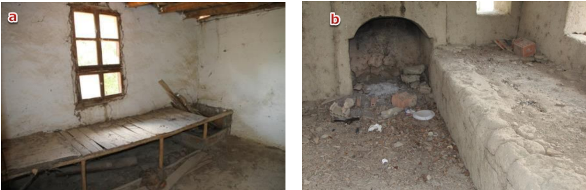
Şekil 11. Tokat bağ evlerinde ahşap sedir (a), kerpiç sedir (b)
