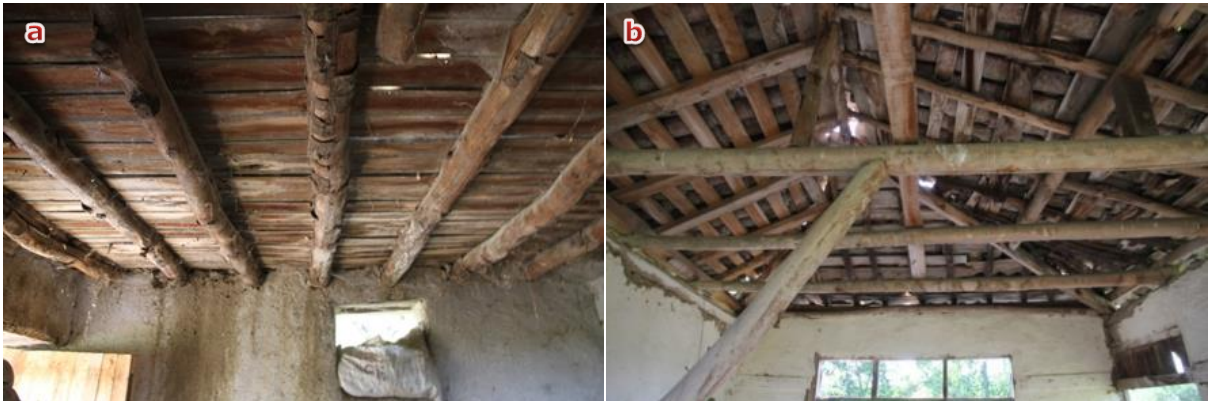
Şekil 16. Ahşap döşeme kirişleri (a), ahşap çatı konstrüksiyonu (b)
