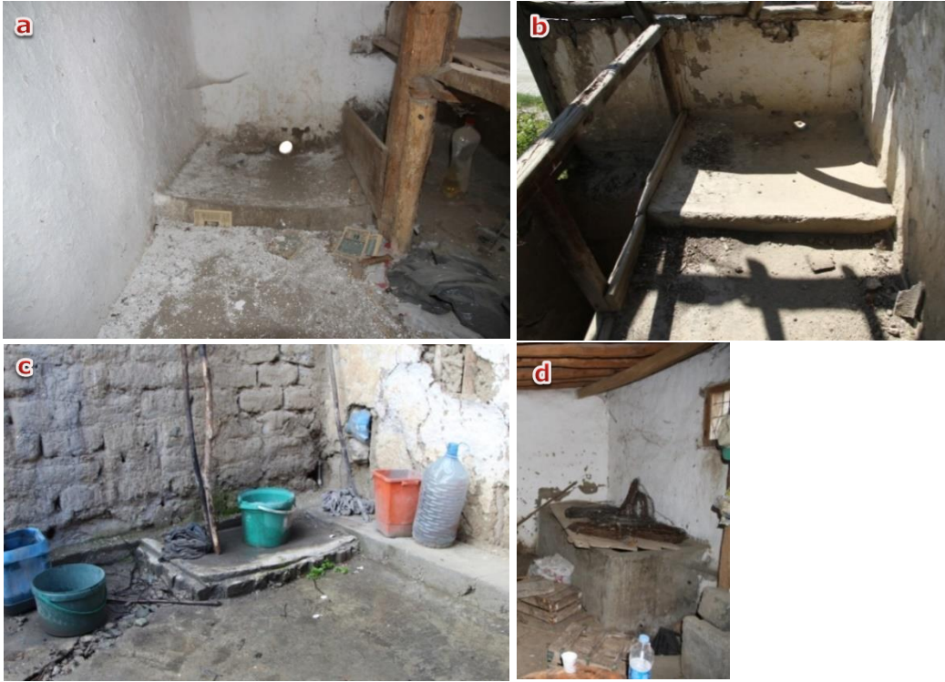
Şekil 12. Bağı evlerinde ıslak hacim, oda içinde çağ (a), balkon ve iş evinde çağ (b,c), tekne şeklinde çağ (c)
