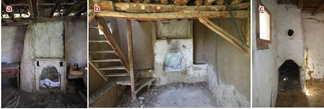
Şekil 10. Tuğla ocak ve nişleri (a), bacasız kerpiç ocak (b), duman tahliyesi tek baca ile sağlanan ocak (c)
