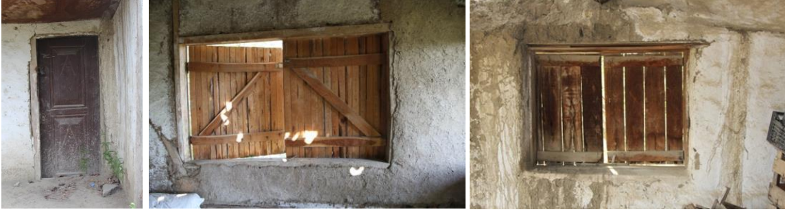
Şekil 13. Bağ evlerinde ahşap kapı ve ahşap kepenk
