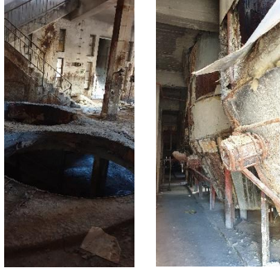
Şekil 10: Sabunhane binası iç mekanındaki kaynatma bölümü ve kaynatma kazanları (Yazar Arşivi, Ağustos, 2021)
