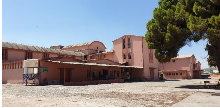
Şekil 14: Gliserin Asit Binası (Yazar Arşivi, Ağustos, 2021)
