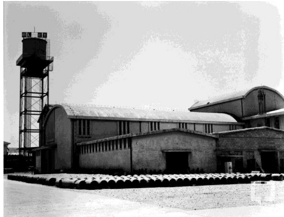
Şekil 16: Yapı grubunun eski bir fotoğrafından genel görünüşü- Su Deposu, Sabunhane ve Sergi Binası. Ön kısımda yerde zeytinyağı varilleri görülmektedir; arkadaki yüksek bina kaynatma binasıdır (Gaziantep Kent Arşivi).
