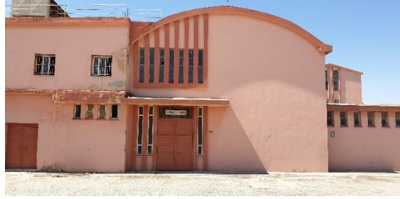
Şekil 6: Sabunhane Binası, Doğu cephesi fotoğrafı (Yazar Arşivi, Ağustos 2021)
