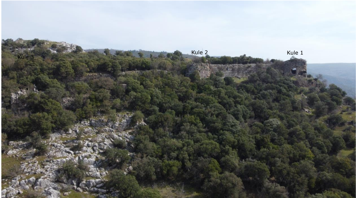
Şekil 7: Güney-güneybatı yönündeki iç sur duvarı, ön sur duvarı ile 1, 2 ve 3 No.lu kuleler
