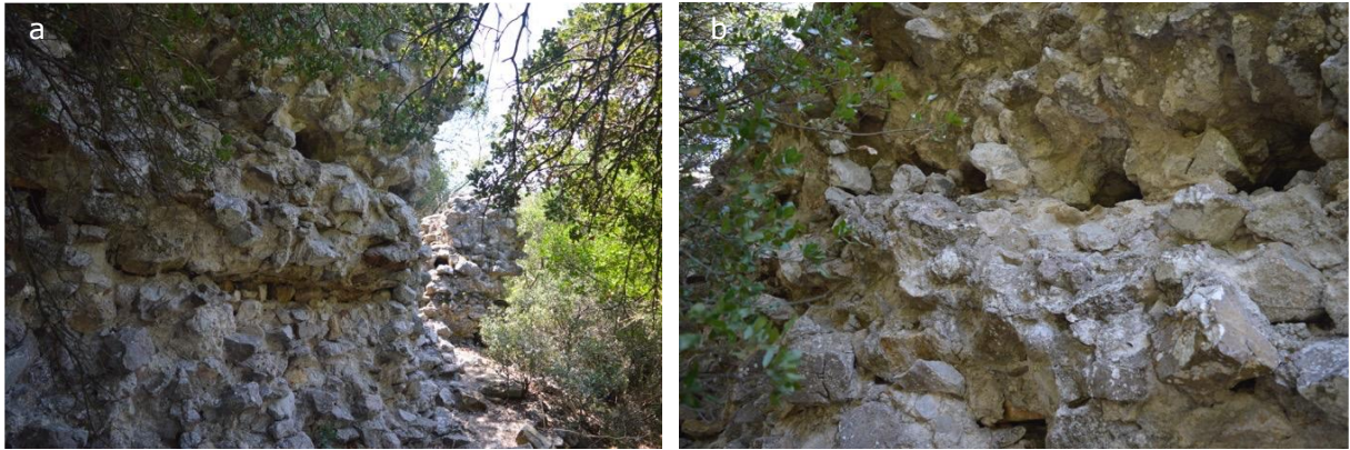
Şekil 12: 2 ve 3 No.lu kuleler arasındaki duvarın çekirdek kısmında görülen hatıl boşlukları
