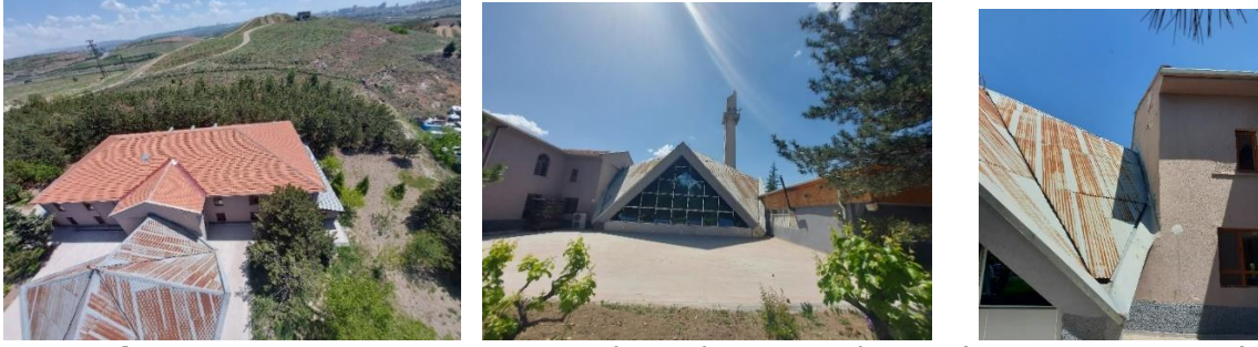
Resim 4. Oto Sanayi Sitesi Cami, mihrap duvarı ve ek yapı (Yazar arşivi, 2022)
