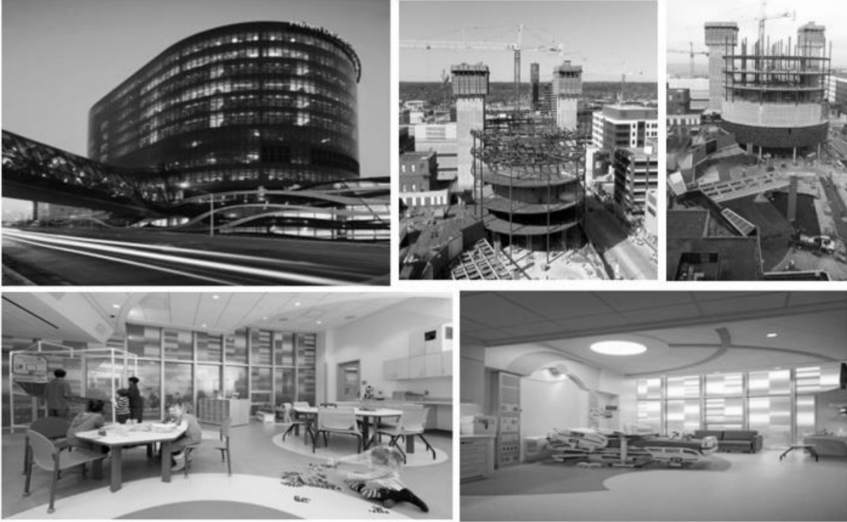
Resim-6: Helen Devos Çocuk Hastanesinde (ABD); bina atığının ve enkazının yüzde 94 kadarı geri dönüştürülerek inşa edilmiştir. Hasta odalarındaki pencereler Arctic Blue yüzde 45 ışık geçirgen (Low-E) camla kaplanmıştır (Url-9)
