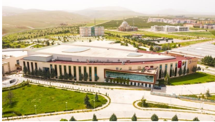
Şekil 29. Konya Teknik Üniversitesince Rektörlük ve Mimarlık ve Tasarım Fakültesi olarak kullanılan yapı (Konya Teknik Üniversitesi, 2021a)
