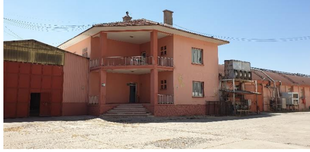
Şekil 3: Yapı adasının ön görünüşü; işletme ve zeytin pres binaları (Yazar Arşivi, Eylül 2022)
