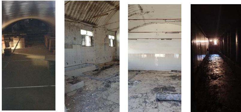
Şekil 5: Zeytin Alım ve Pres Binası iç görünüşleri, tonoz çatı, seramik kaplı kanallar ve yağ tankları bölümünden görünüşler (Yazar Arşivi, Eylül 2022)
