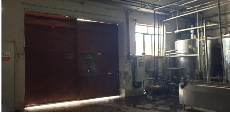
Şekil 6: Zeytin Pres Binası kuzey giriş kapısı ve iç görünüşü (Yazar Arşiv, Eylül 2022)
