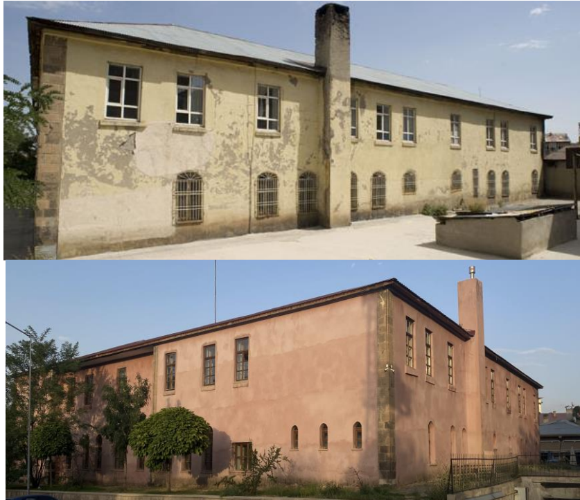
Fotoğraf-38,39: Muş Eski Hükümet Konağı Güney Cephesi Onarım Öncesi ve Sonrası Genel Görünüşleri (Ş. Öztürk)
