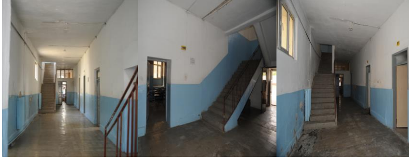
Fotoğraf-06-08: Muş Eski Hükümet Konağı Zemin Kat İç Mekan Koridor Görünüşleri (Ş. Öztürk)
