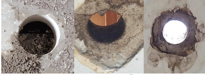
Fotoğraf-52-54: Muş Eski Hükümet Konağı Betonarme Döşeme Karot Görünüşleri (Ş. Öztürk)
