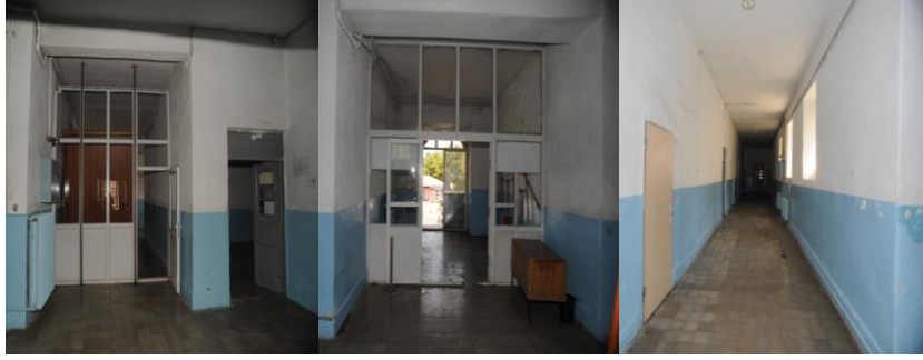
Fotoğraf-09-11: Muş Eski Hükümet Konağı Zemin Kat İç Mekan Koridor Görünüşleri (Ş. Öztürk)
