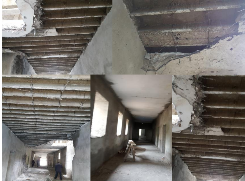
Fotoğraf-55-59: Muş Eski Hükümet Konağı Betonarme Döşeme Onarım Görünüşleri (Ş. Öztürk)
