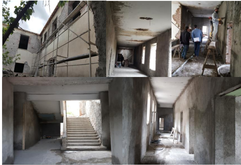
Fotoğraf-62-66: Muş Eski Hükümet Konağı Duvar Onarım Görünüşleri (Ş. Öztürk)
