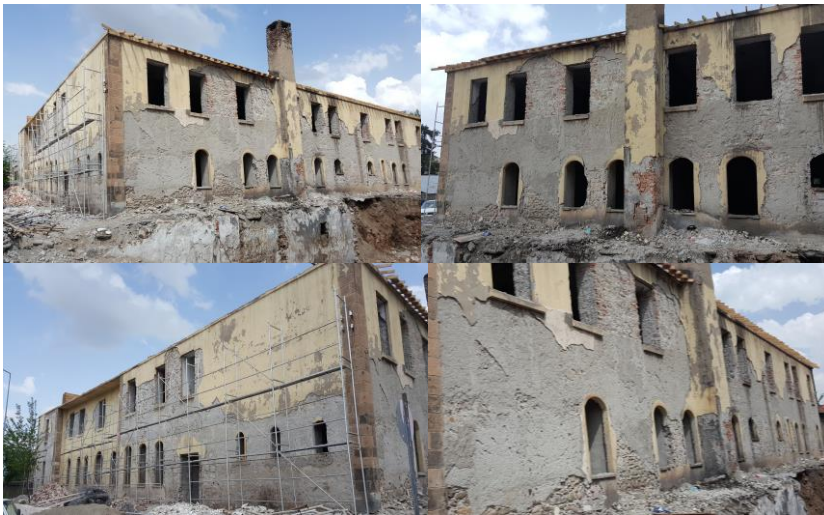
Fotoğraf-48-51: Muş Eski Hükümet Konağı Cephe Onarım Çalışma Görünüşleri (Ş. Öztürk)
