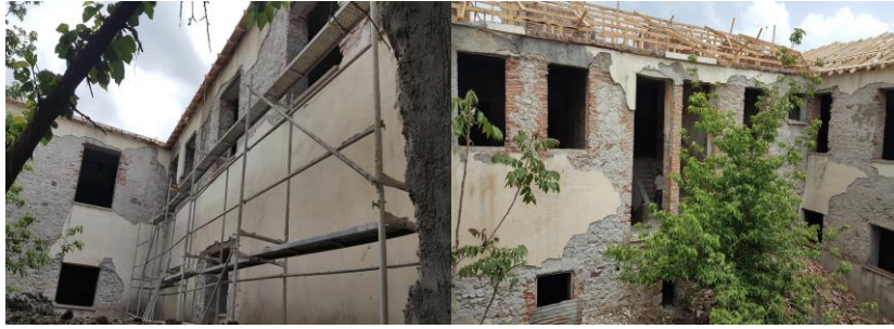
Fotoğraf-46,47: Muş Eski Hükümet Konağı Cephe Onarım Çalışma Görünüşleri (Ş. Öztürk)
