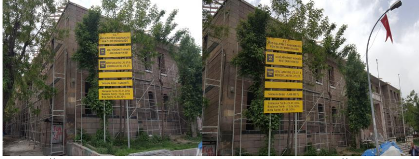
Fotoğraf-45,46: Muş Eski Hükümet Konağı Cephe Onarım Görünüşleri (Ş. Öztürk)
