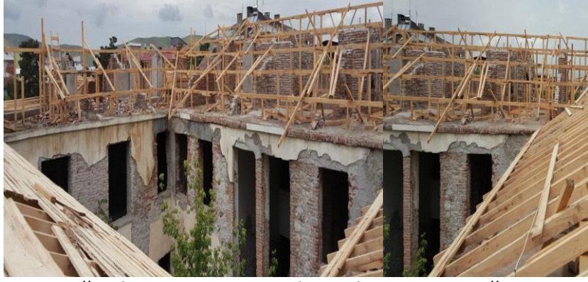
Fotoğraf-60,61: Muş Eski Hükümet Konağı Çatı Onarım Görünüşleri (Ş. Öztürk)
