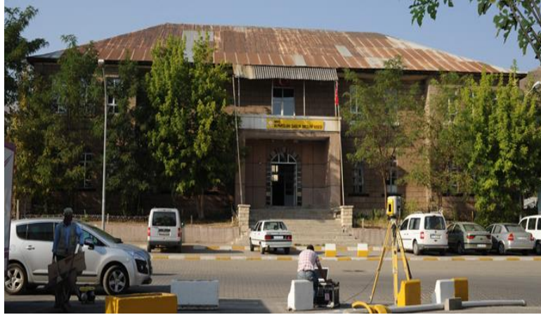
Fotoğraf-36: Muş Eski Hükümet Konağı Kuzey Cephesi Onarım Öncesi Genel Görünüşü (Ş. Öztürk)
