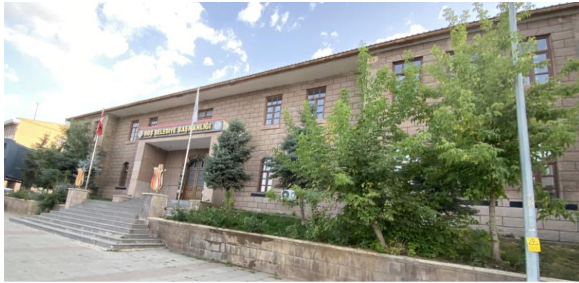
Fotoğraf-69: Muş Eski Hükümet Konağı Onarım Sonrası Görünüşü (Ş. Öztürk)
