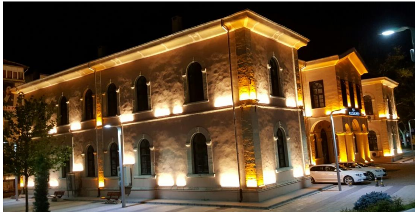
Fotoğraf-60:Eski Hükümet Konağı Onarım Sonrası Kuzeydoğu Görünüşü (Ş. Öztürk)
