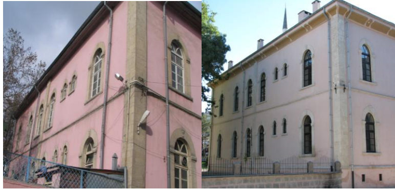
Fotoğraf-29,30: Eski Hükümet Konağı Batı Cephe Onarım Öncesi-Sonrası Görünüşleri (Ş. Öztürk)
