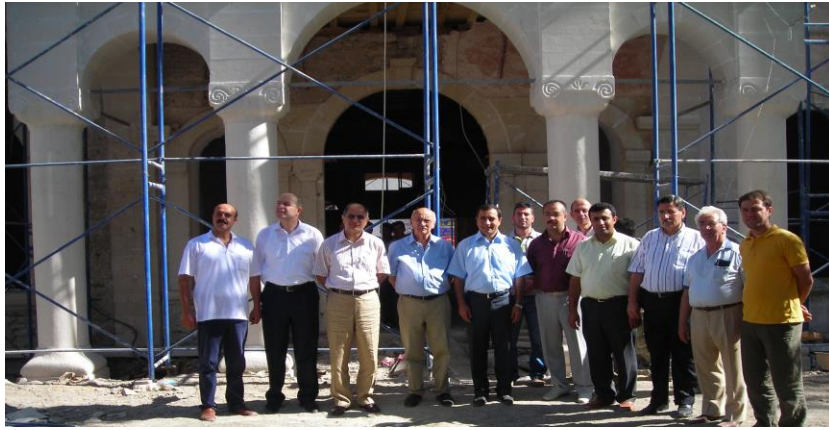
Fotoğraf-64: Eski Hükümet Konağı Onarım Çalışmaları Bölge Valilerinin İnceme Görünüşü (Ş. Öztürk)
