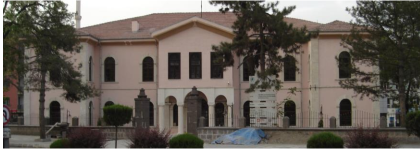
Fotoğraf-26: Eski Hükümet Konağı Kuzey Cephe Onarım Sonrası Görünüşü (Ş. Öztürk)
