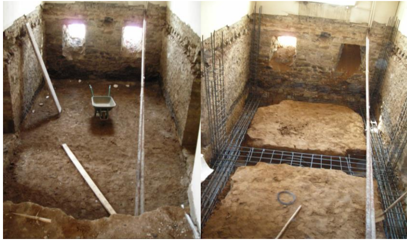
Fotoğraf-55,56: Eski Hükümet Konağı Bodrum Kat Onarım Görünüşleri (Ş. Öztürk)
