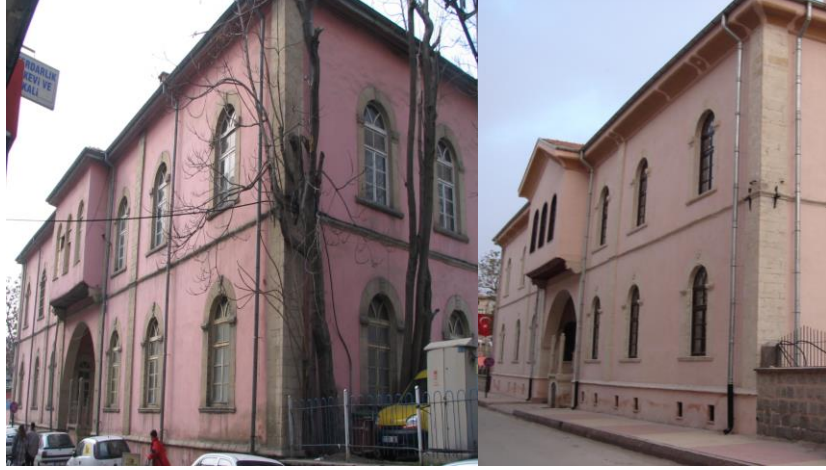
Fotoğraf-31,32: Eski Hükümet Konağı Onarım Güney Cephe Onarım Öncesi-Sonrası Görünüşleri (Ş. Öztürk)
