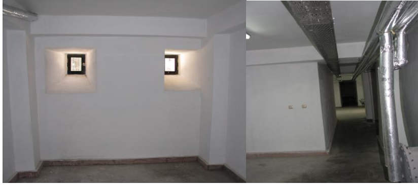
Fotoğraf-14,15: Eski Hükümet Konağı Bodrum Kat Onarım Sonrası İç Mekan Görünüşleri (Ş. Öztürk)
