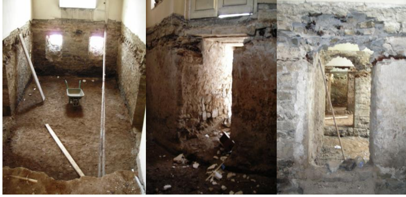
Fotoğraf-11-13: Eski Hükümet Konağı Bodrum Kat Kazı Çalışma Görünüşleri (Ş. Öztürk)
