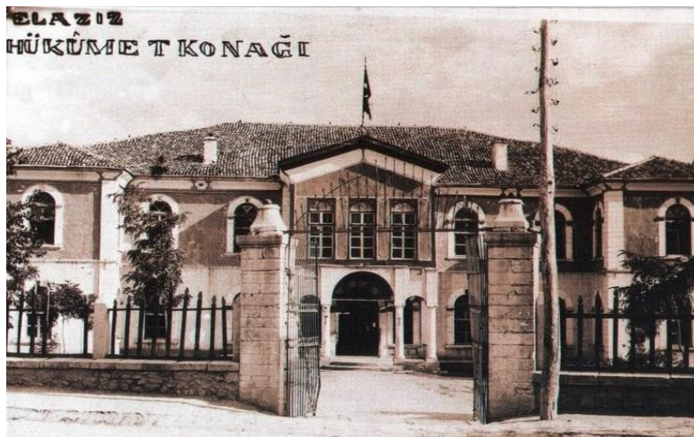
Fotoğraf-8: Eski Hükümet Konağı Kuzey Görünüşü (1930), (Anonim)
