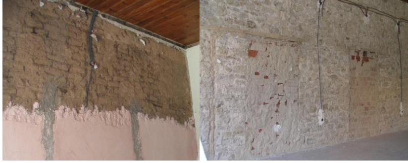
Fotoğraf-36,37: Eski Hükümet Konağı Kerpiç Duvar Onarım Görünüşleri (Ş. Öztürk)
