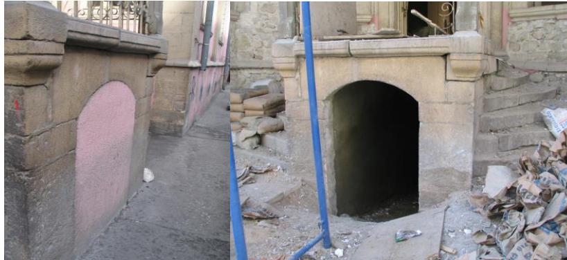
Fotoğraf-9,10: Eski Hükümet Konağı Bodrum Giriş Kapısı Görünüşü (Ş. Öztürk)
