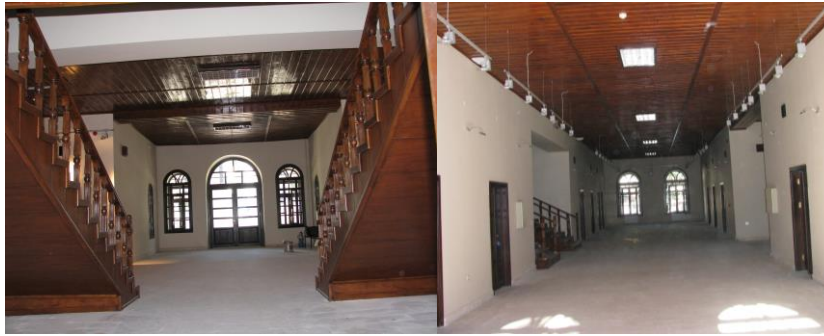
Fotoğraf-18,19: Eski Hükümet Konağı Zemin Kat Onarım Sonrası Koridor Görünüşleri (Ş. Öztürk)
