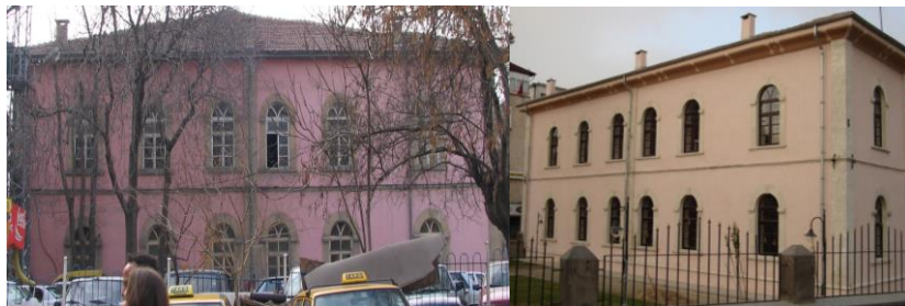
Fotoğraf-27,28: Eski Hükümet Konağı Onarım Doğu Cephe Onarım Öncesi-Sonrası Görünüşleri (Ş. Öztürk)
