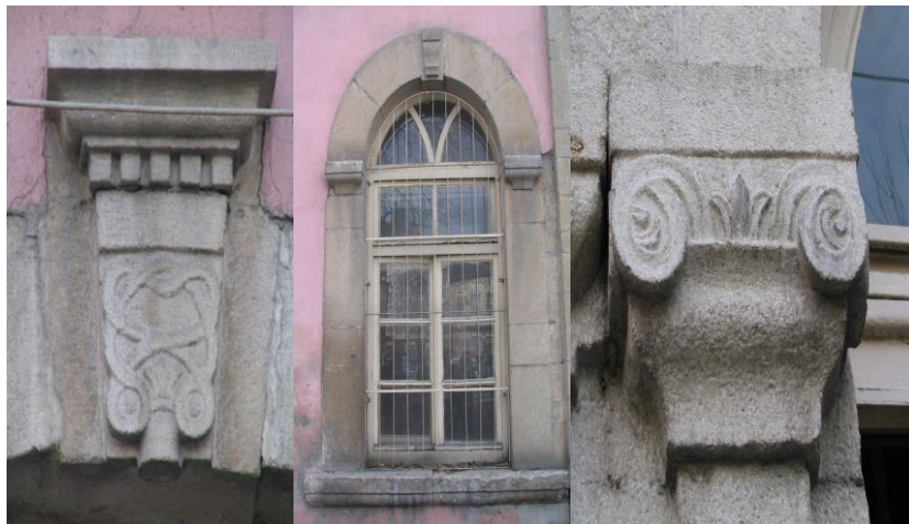
Fotoğraf-33-35: Eski Hükümet Konağı Onarım Güney Cephe Onarım Öncesi-Sonrası Görünüşleri (Ş. Öztürk)
