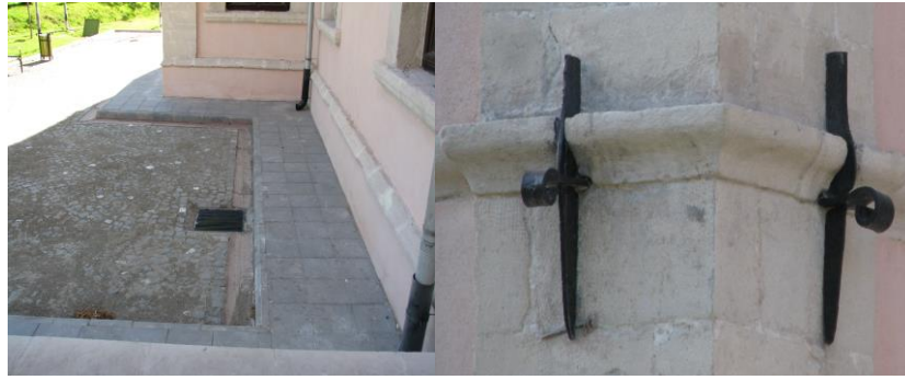
Fotoğraf-49,50: Hükümet Konağı Zemin Küp Taş, Tretuvar Yonu Taş ve Metal Köşe Kılıçlama Gergi Katıl Kullanım Görünüşleri (Ş. Öztürk)
