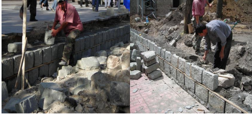
Fotoğraf-59,60: Eski Hükümet Konağı Çevre Duvarı Yapım ve Onarım Görünüşleri (Ş. Öztürk)
