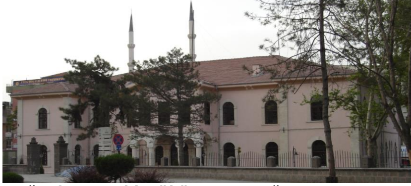
Fotoğraf-64: Eski Hükümet Konağı Onarım Sonrası Kuzey Görünüşü (Ş. Öztürk)
