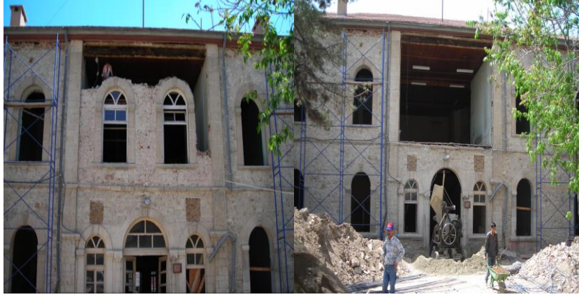
Fotoğraf-53,54: Eski Hükümet Konağı Cephe Onarım Görünüşleri (Ş. Öztürk)
