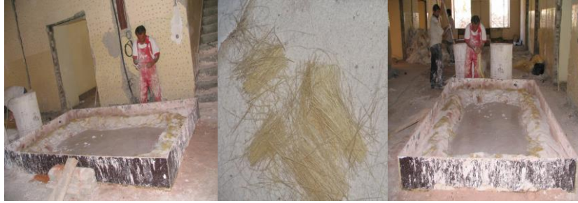
Fotoğraf-46-48: Eski Hükümet Konağı Horasan Harcı Hazırlama Görünüşleri (Ş. Öztürk)
