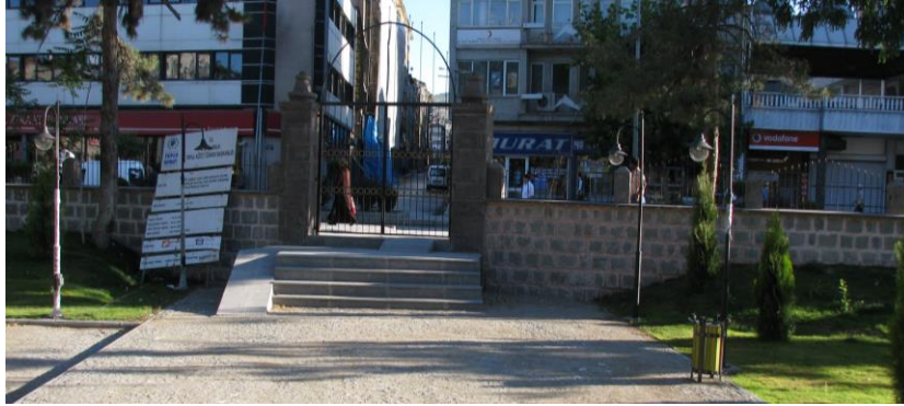
Fotoğraf-58: Eski Hükümet Konağı Onarım Sonrası Pencere Görünüşü (Ş. Öztürk)
