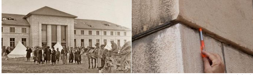
Resim 2. Depremin hemen sonrasında Erzincan Garı ve 2 santimetrelilik kayma (Url 3).
