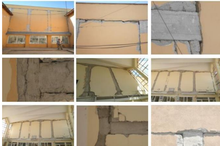
Resim 10. Van Tren Garı B bloktaki kolon-kiriş birleşimlerinde ve duvarlarda oluşan hasarlar (Akköse, M. ve Sunca, F., 2016).
