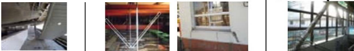
Resim 7. İstasyon tavanındaki çökme ve çapraz destekle güçlendirilmesi; duvardaki hasar ve çapraz destekle güçlendirilmesi (East Japan Railway Company, 2012).
