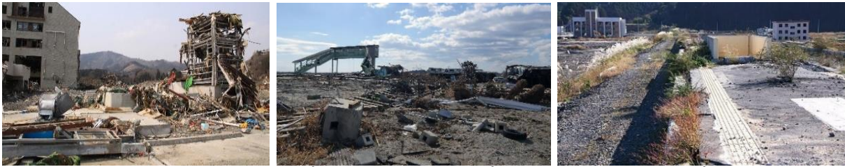
Resim 4. (sırasıyla) Onagawa İstasyonu, Shinchi İstasyonu, Shizugawa İstasyonunun depremden sonraki durumu (Url 5).
