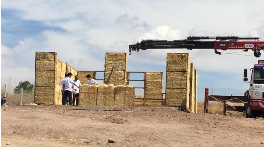
Şekil 13. Ankara’da sıkıştırılmış saman balya modülünden yapılan konutun inşa aşaması (Duman,2020)
