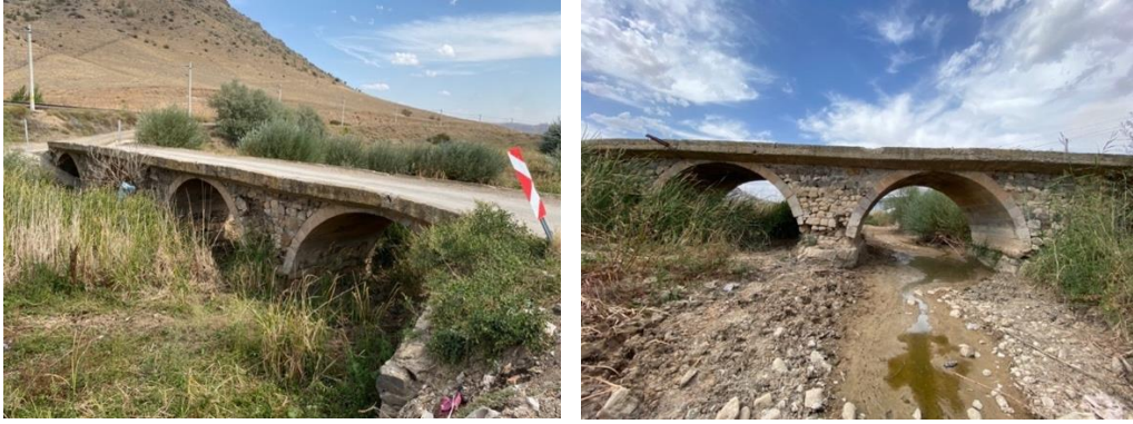
Şekil 18. Delice Köprüsüne Ait Görünüş (S. Sezer, 2021)
