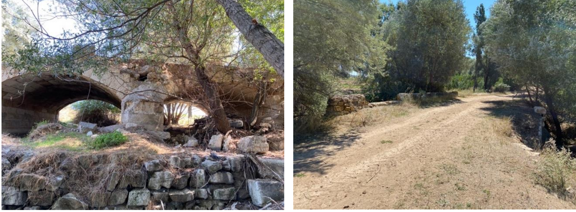
Şekil 10. Ak Köprüye Ait Fotoğraflar (S. Sezer, 2021)
