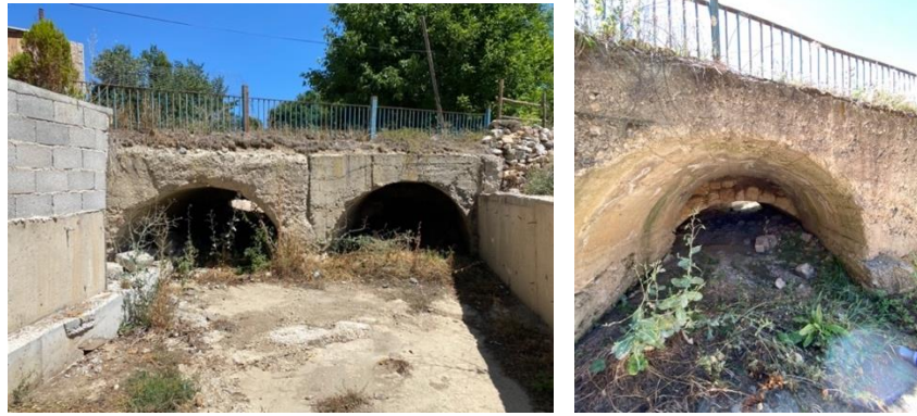
Şekil 16. Köklü Dere-I Köprüsüne Ait Görünüş (S. Sezer, 2021)
