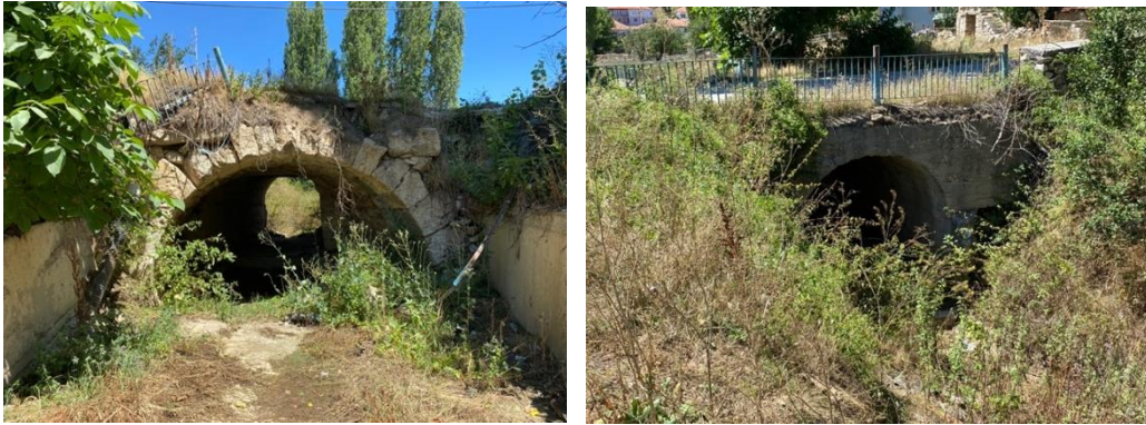
Şekil 17. Köklü Dere-II Köprüsüne Ait Görünüş (S. Sezer, 2021)
