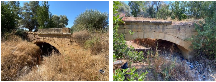
Şekil 22. Aşağıbağlar Köprüsüne Ait Görünüş (S. Sezer, 2021)
