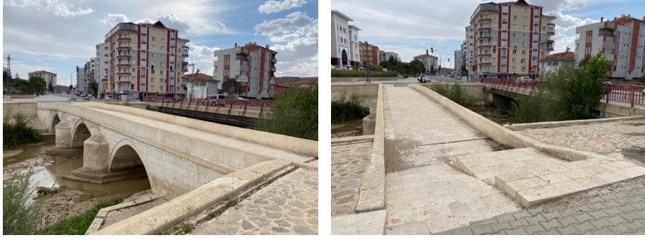
Şekil 6. Koşa Köprüsü Restorasyon Sonrasına Ait Görünüş (S. Sezer, 2021)
