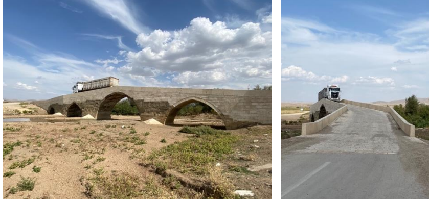
Şekil 8. Tuzla Köprüsüne Restorasyon Sonrasına Ait Görünüş (S. Sezer, 2021)
