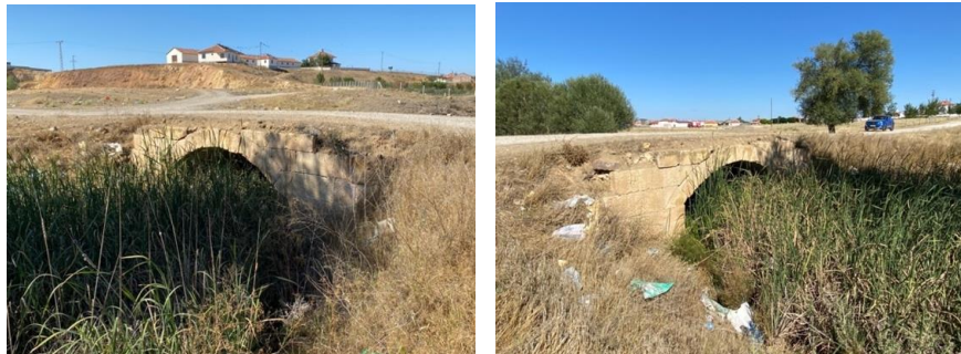
Şekil 21. Doğankent Köprüsüne Ait Görünüş (S. Sezer, 2021)
