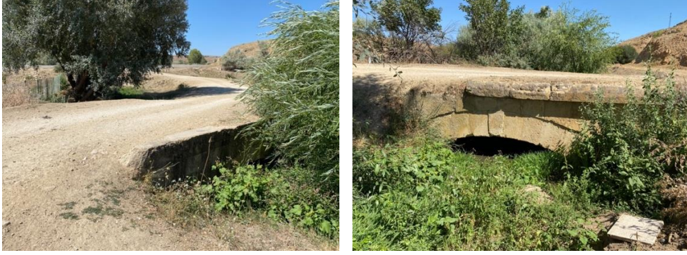
Şekil 14. Osmanpaşa Köprüsüne Ait Görünüş (S. Sezer, 2021)
