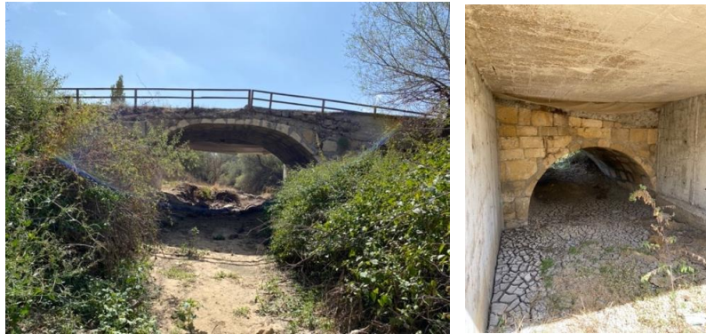
Şekil 19. Aşağıelmahacılı Köyü Köprüsüne Ait Görünüş (S. Sezer, 2021)
