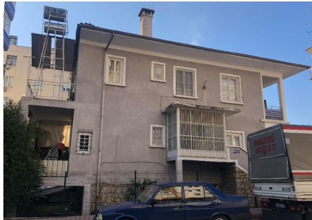
Şekil 16: Sonradan eklenen balkon kısmının kuzey cepheden görünüşü
