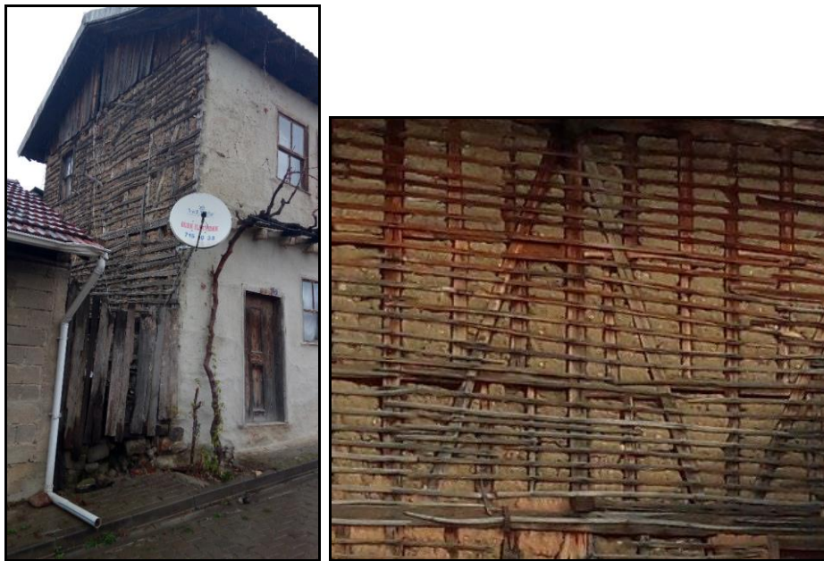
Şekil 16. Tahtaköprü Evlerinde Bağdadi Duvar Örnekleri (Yazar Arşivi)
