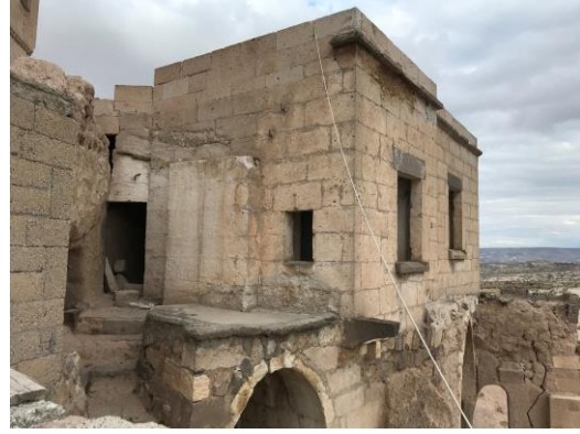
Şekil 4.4. Uçhisar kaya oyma+yığma yapı Parsel:765-766 (Budak, 2021)
