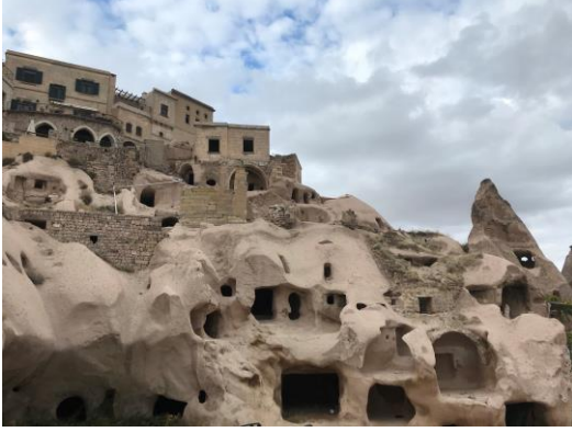
Şekil 4.4. Uçhisar kaya oyma+yığma yapı Parsel:765-766 (Budak, 2021)
