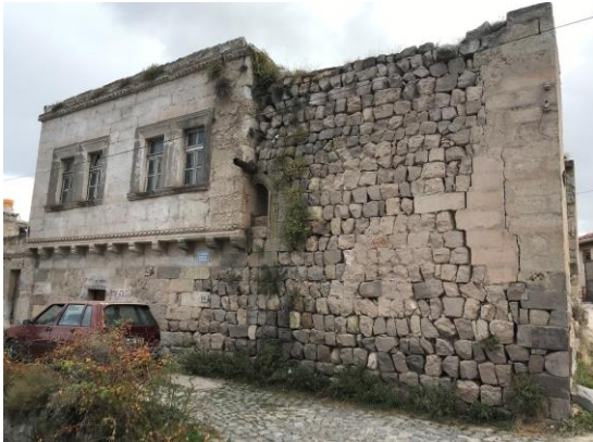
Şekil 4.5. Uçhisar yığma yapı örnekleri (Budak, 2021)
