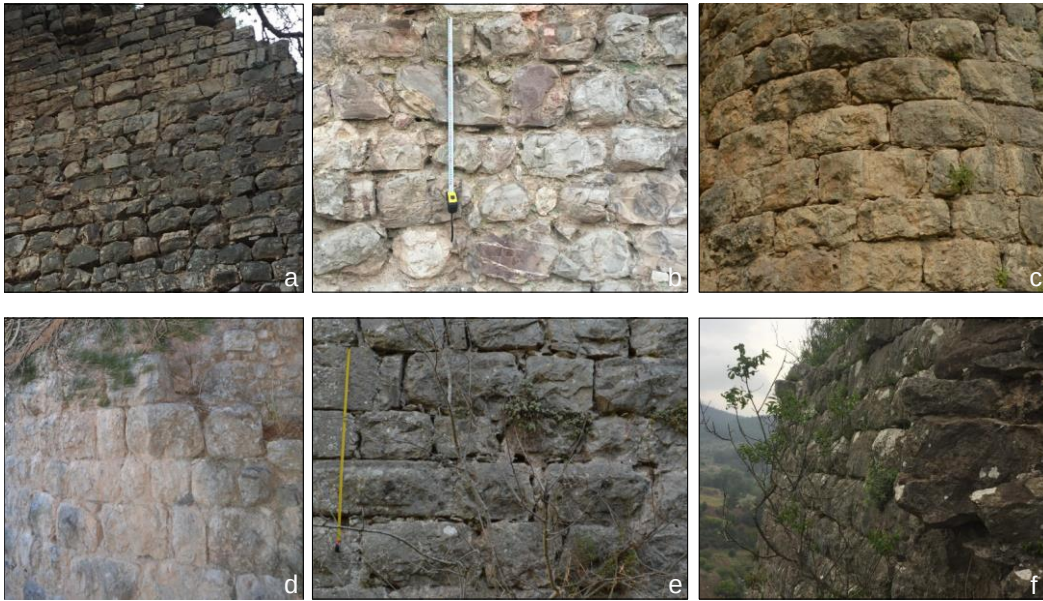
Şekil 10. a. Doğu beden duvarı yapı sistemi b. Doğu beden duvarı iç cephesi c. B burcu d. I kütle e. A kütle batı cephesi f. L kütle batı cephesi
