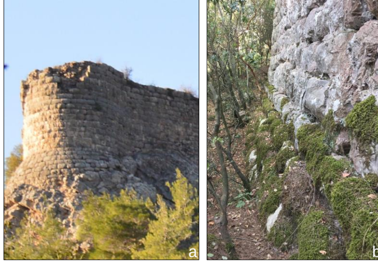
Şekil 9. a. Ahmedek burç eteği b. İç kale perde duvarı ampattmanı
