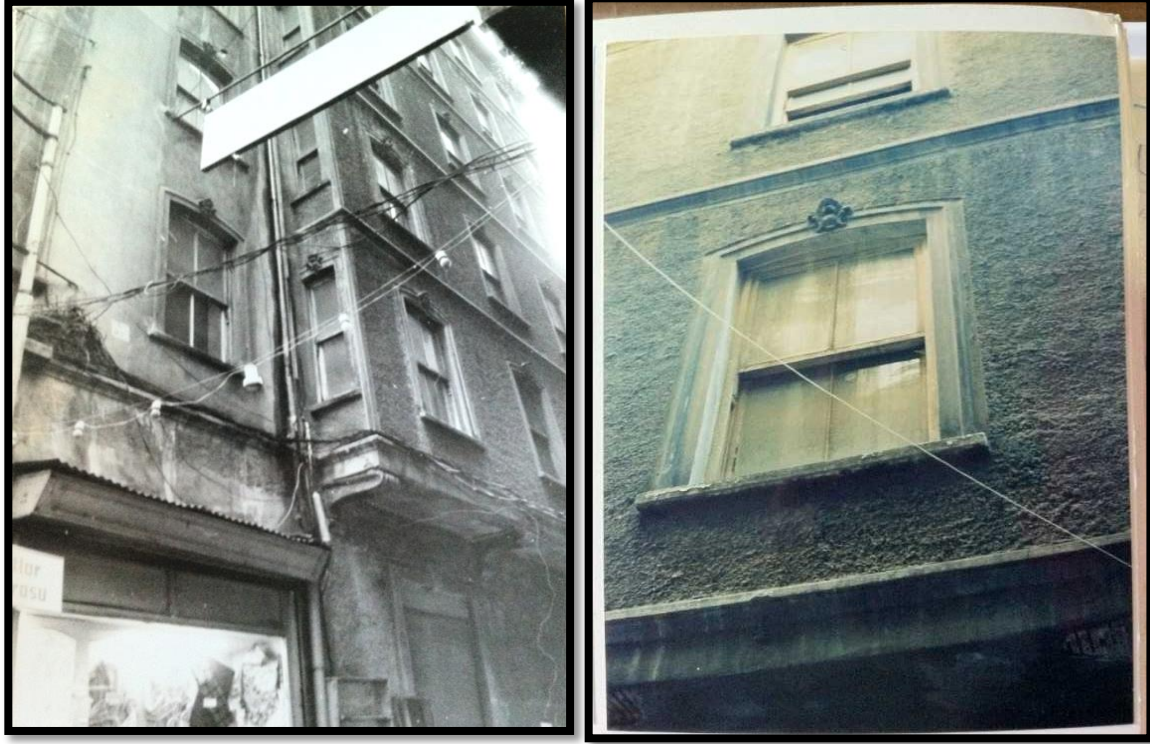
Şekil 7. Yapının yeniden işlevlendirme öncesi yan cephe detayları [5]
