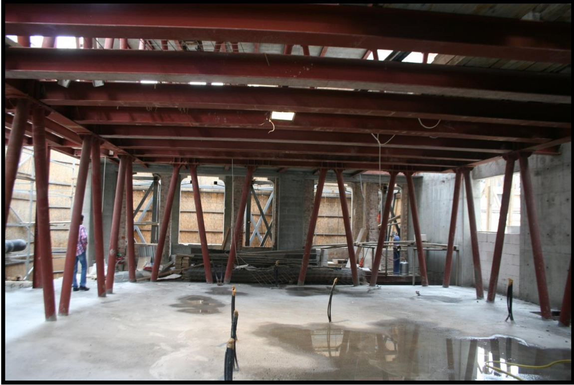
Şekil 17. Yapının yeniden işlevlendirme sonrası taşıyıcı sistem detayı [2]
