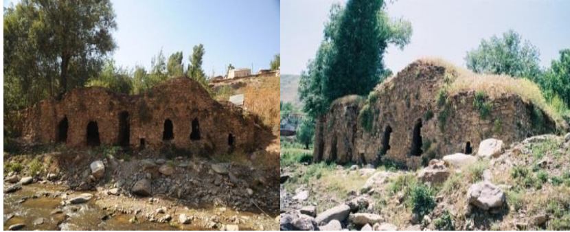
Şekil 19,20. Migren Hamamı Güney Görünüşleri (Ş. Öztürk)
