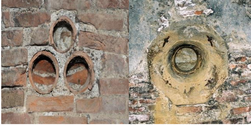
Şekil 11,12. Migren Hamamı Sıcaklık Bölümü Baca ve Aks-i Seda Küpleri Görünüşleri (Ş. Öztürk)
