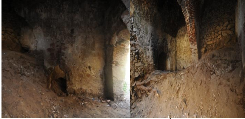
Şekil 33,34. Migren Hamamı İç Mekan Görünüşleri (Ş. Öztürk)
