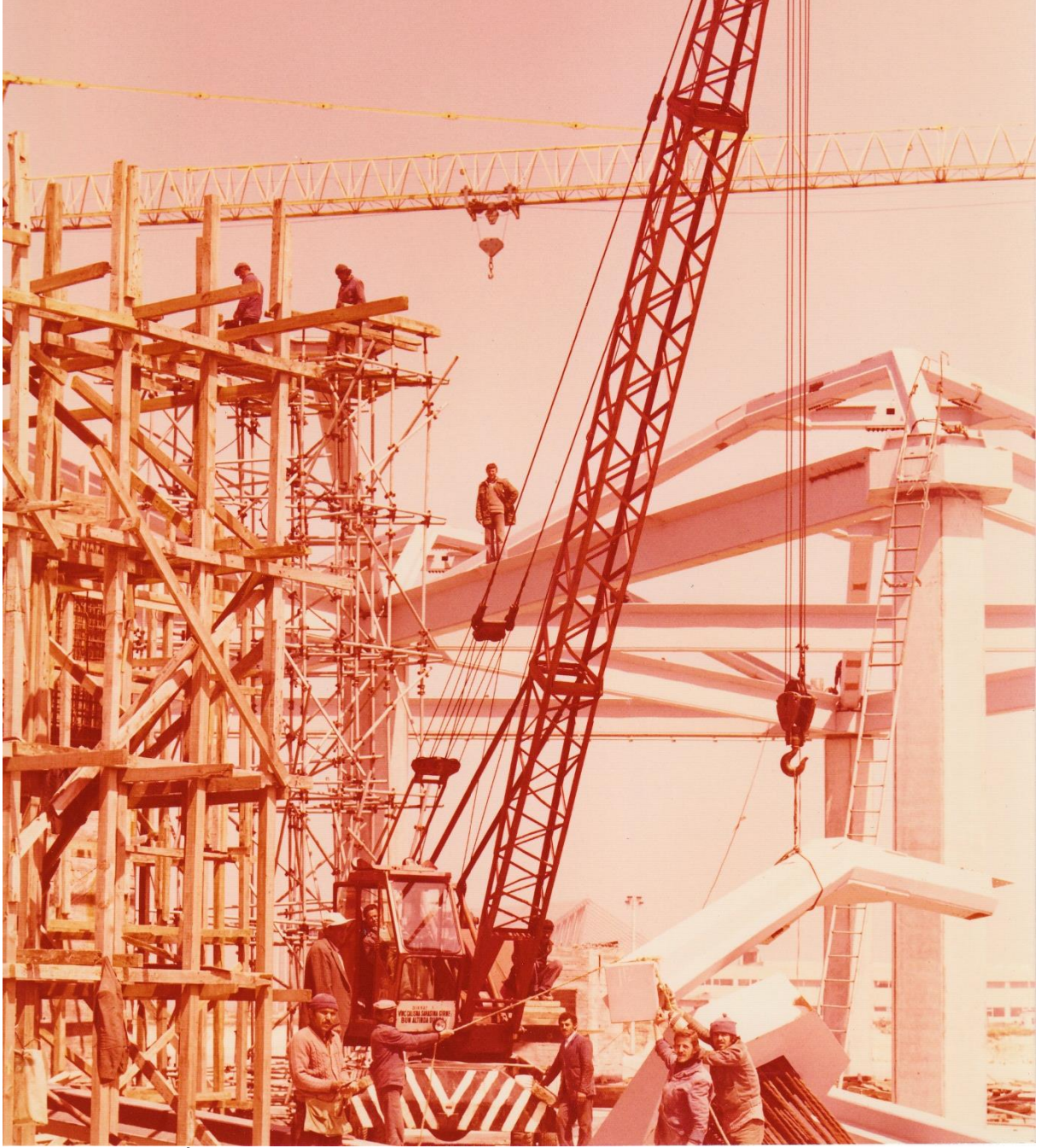
Şekil 1.8 İç Hatlar Terminal Binası Yapım Aşaması-1 (Salt Araştırma-3, 2021)
