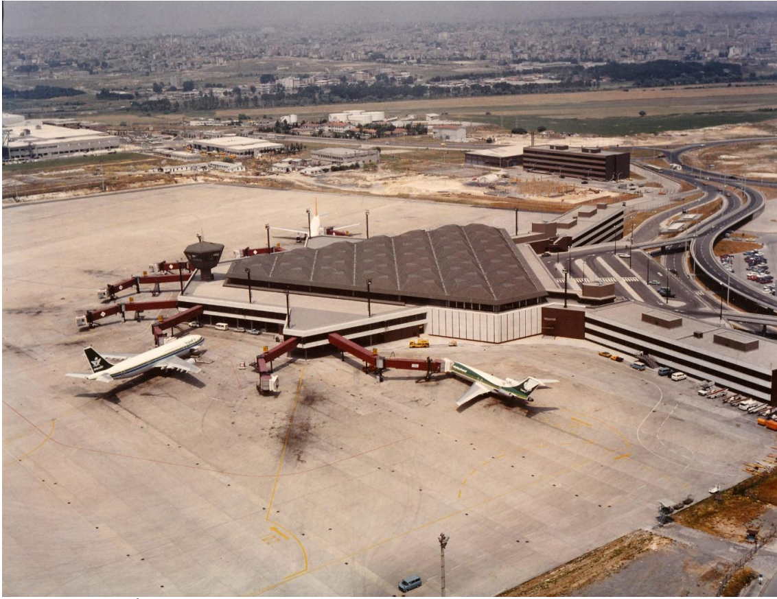
Şekil 1.13 İç Hatlar Terminal Binası Genel Görünüm (Salt Araştırma-5, 2021)
