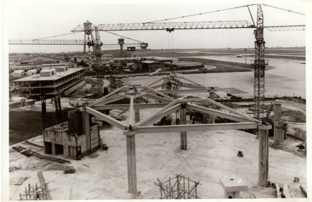
Şekil 1.10 İç Hatlar Terminal Binası Yapım Aşaması-3 (Salt Araştırma-3, 2021)
