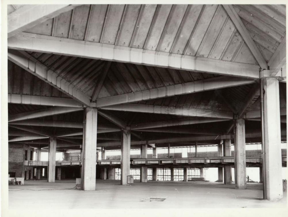
Şekil 1.9 İç Hatlar Terminal Binası Yapım Aşaması-2 (Salt Araştırma-3, 2021)
